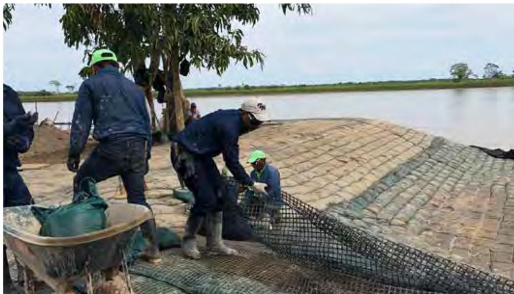
Obra control de inundación y protección margen derecha río Arauca
