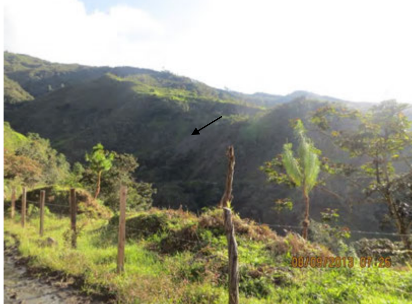
Fotografía 28. Vista del deslizamiento que afecta la vía.
