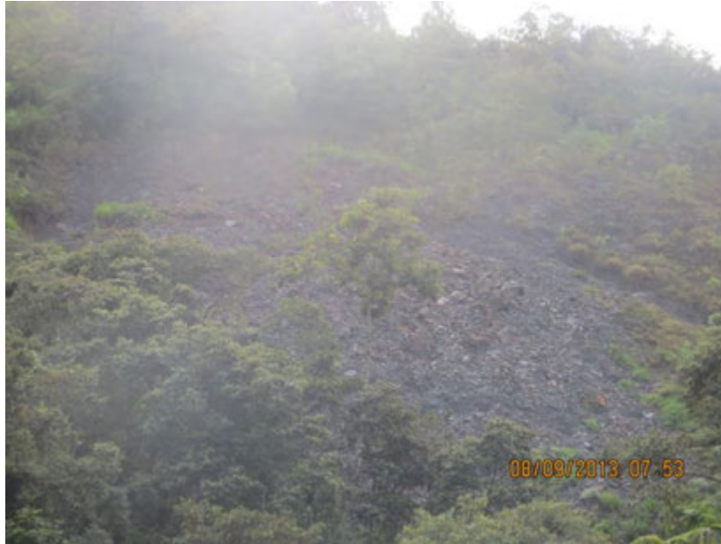
Fotografía 29. Vista del deslizamiento desde la vía.
