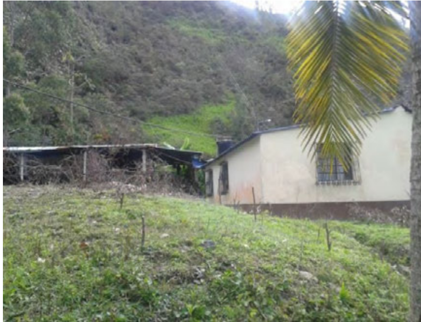
Fotografía 3. TEJIDO URBANO DISCONTINUO
