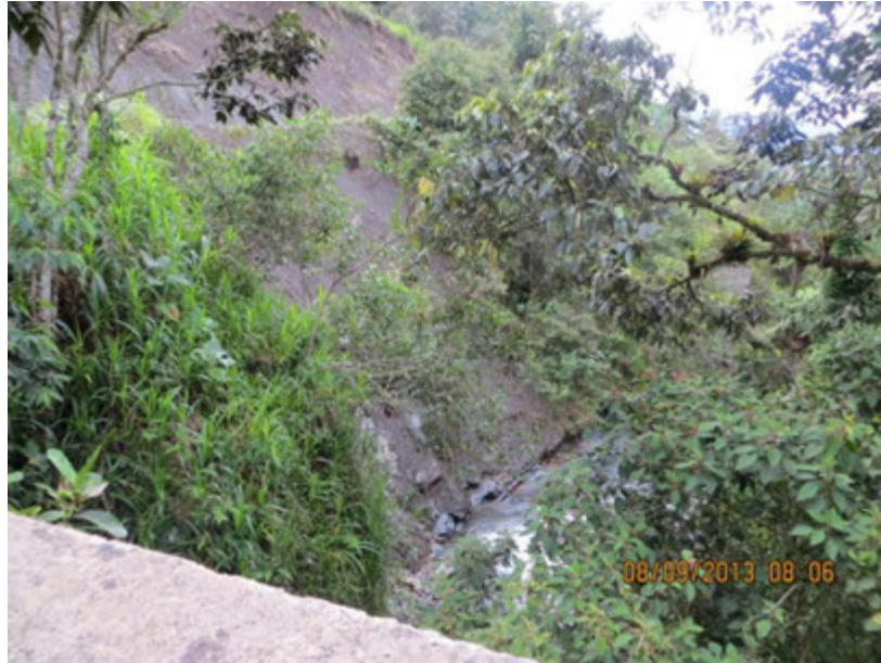
Fotografía 30. Vista del deslizamiento en afectación al río.
