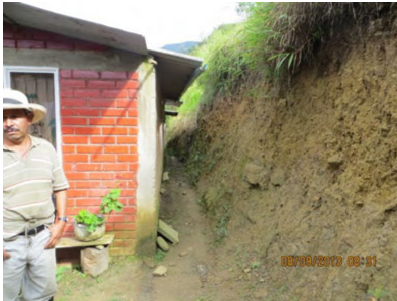
Fotografía 34. Vista de la parte posterior de la vivienda.
