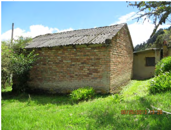
Fotografía 30. Vivienda parte alta del deslizamiento
