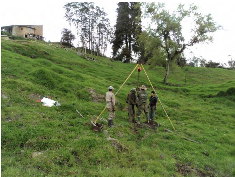
Fotografía 17. Perforación realizada en la zona de estudio
