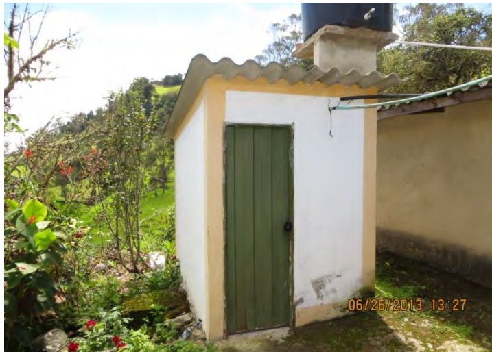
Fotografía 25. Unidad sanitaria de vivienda evaluada.
