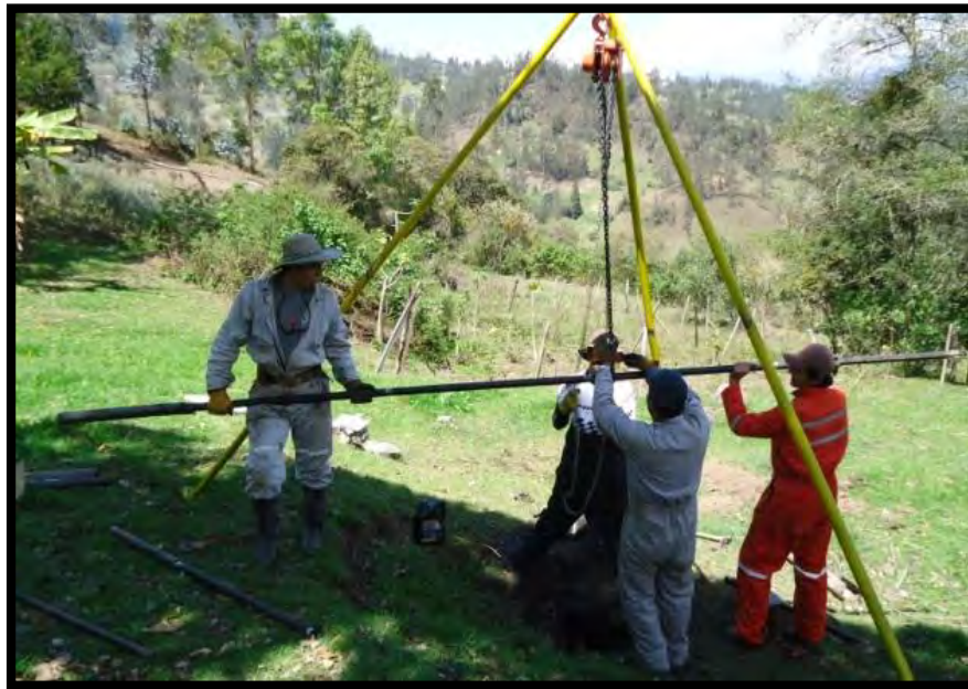
Fotografía 20. Perforación realizada en la zona de estudio
