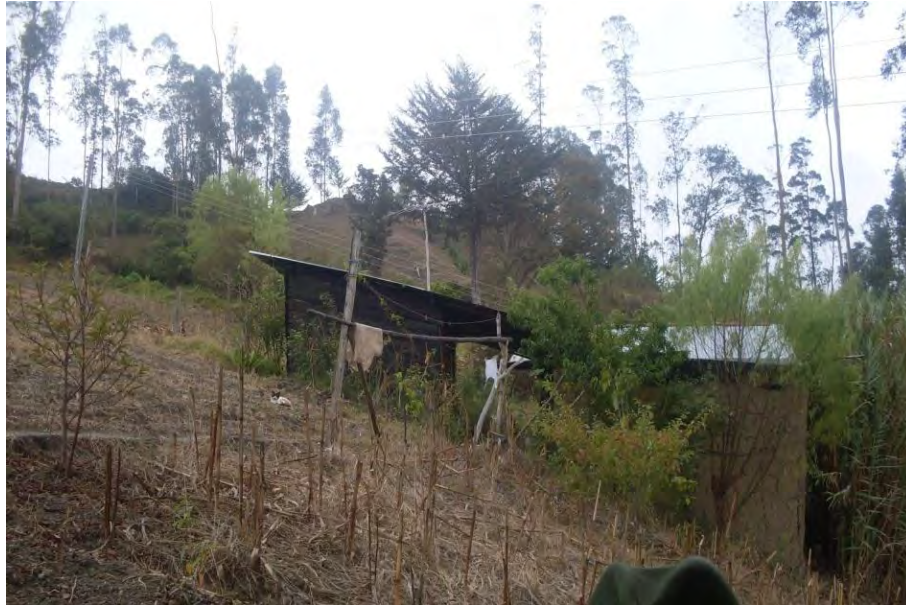
Fotografía 31. Vivienda habitada en terreno inestable
