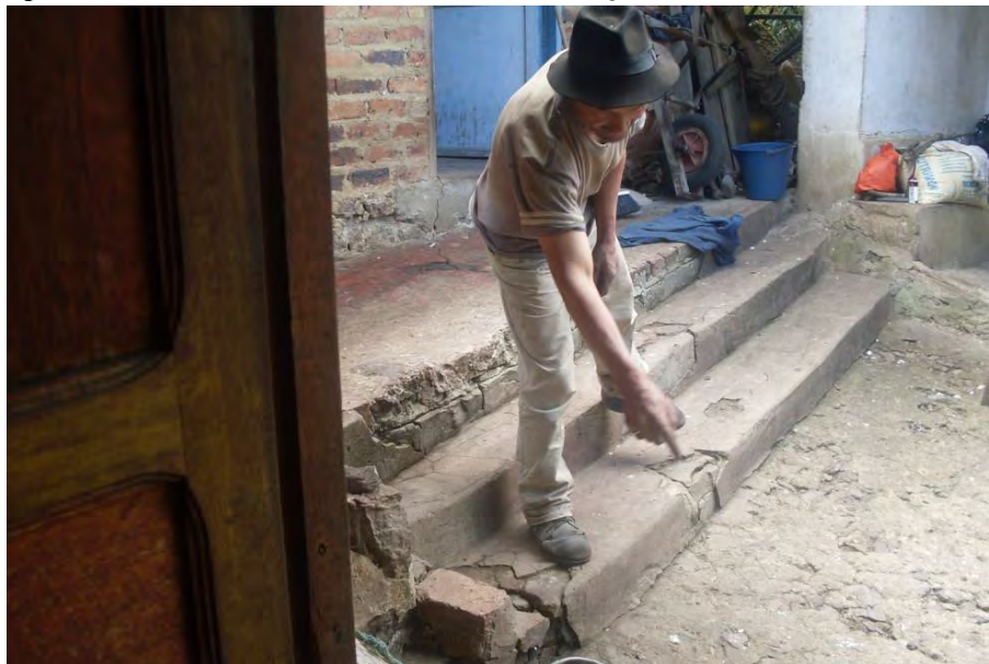
Fotografía 35. Vivienda visiblemente afectada por el movimiento en masa.
