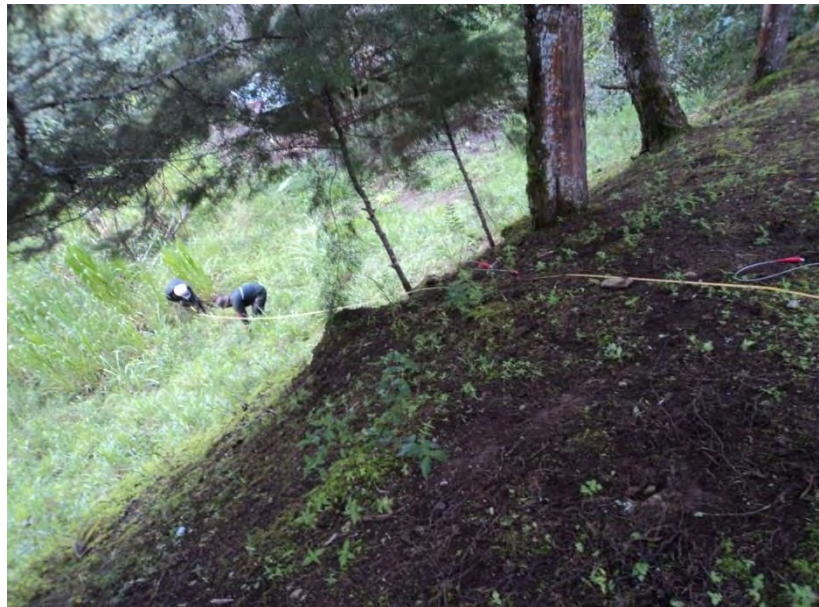
Fotografía 17. Parte media del deslizamiento.
