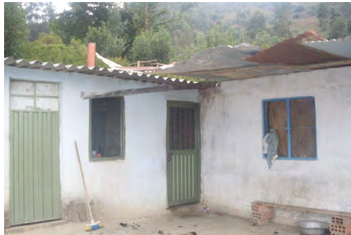
Fotografía 33. Vivienda vereda Bayeta.
