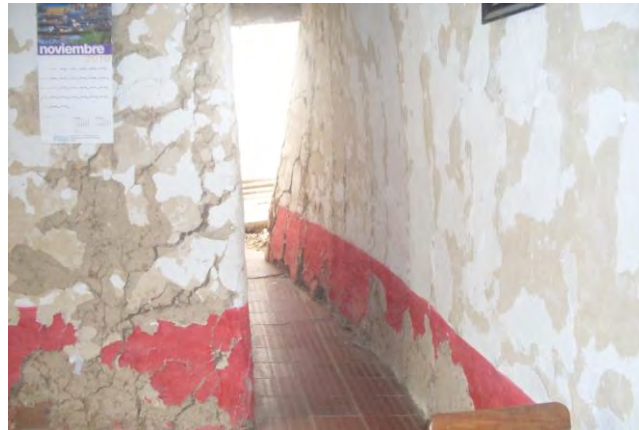
Fotografía 38. Paredes de vivienda antigua del sector.
