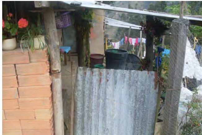
Fotografía 34. Vivienda vereda Bayeta.
