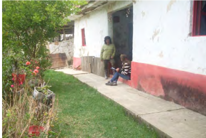
Fotografía 30. Vivienda habitada en el sector evaluado.
