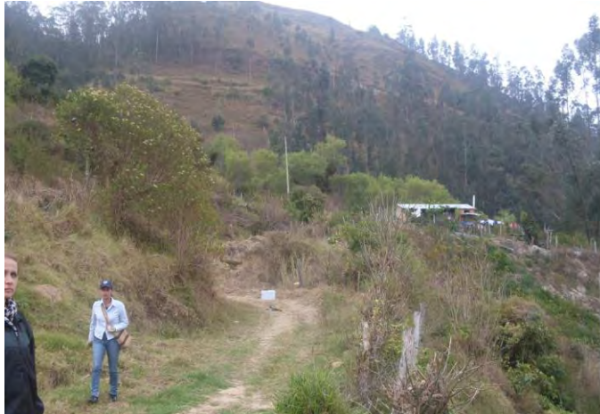
Fotografía 28. Vista de parte del área afectada por el deslizamiento.
