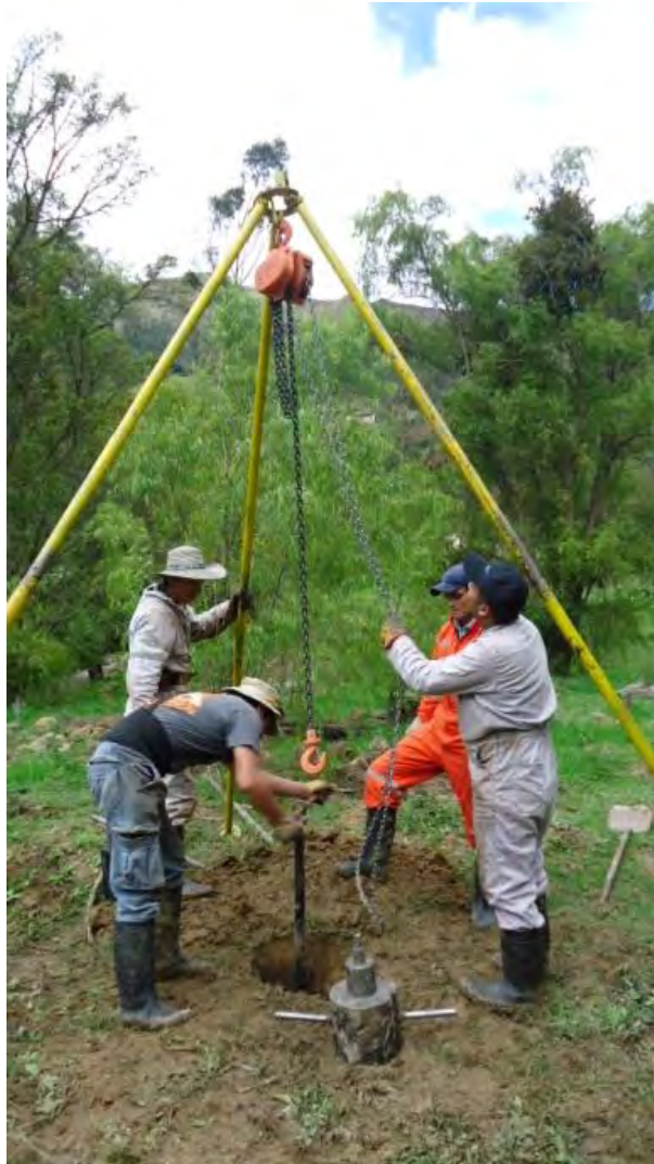
Fotografía 21. Perforación realizada en la zona de estudio
