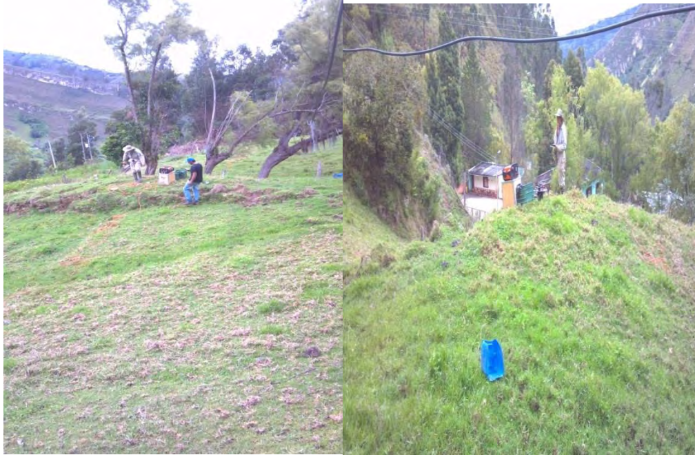
Fotografía 19. Parte alta del deslizamiento.
