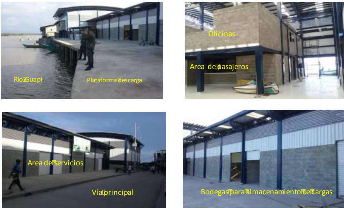
Fotografía 3-1 Vista general del muelle de Guapi
