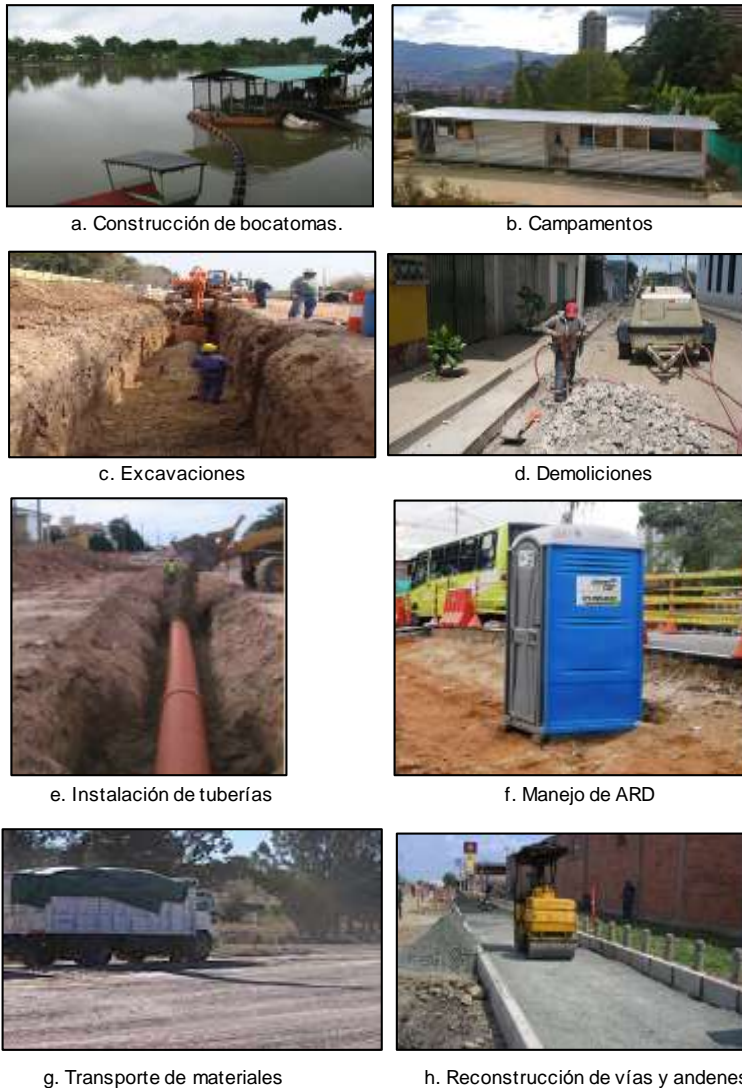
Figura 3-5 Algunas actividades tecnológicas de construcción de acueductos y alcantarillados
