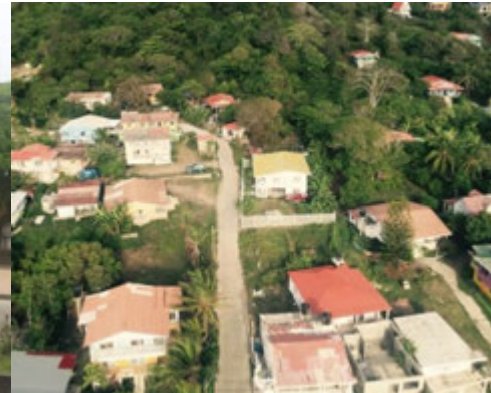
Construcción de vivienda rural
