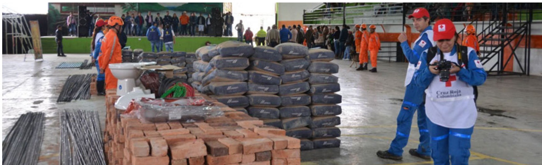
Entrega de materiales de construcción. Chitagá – Norte de Santander
