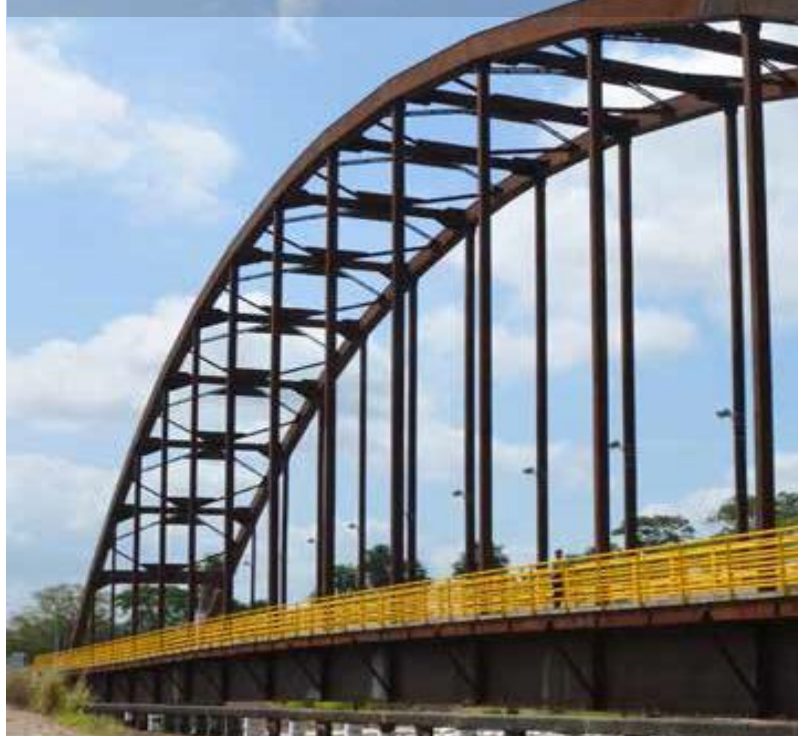
Construcción Puente Tame sobre el Río Tame - Arauca
