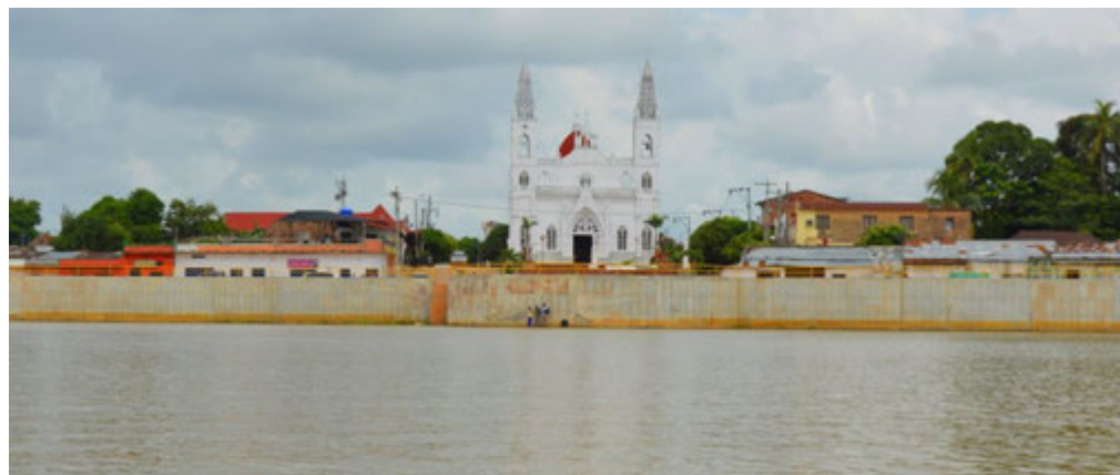
Muro de Contención. Ayapel - Córdoba
