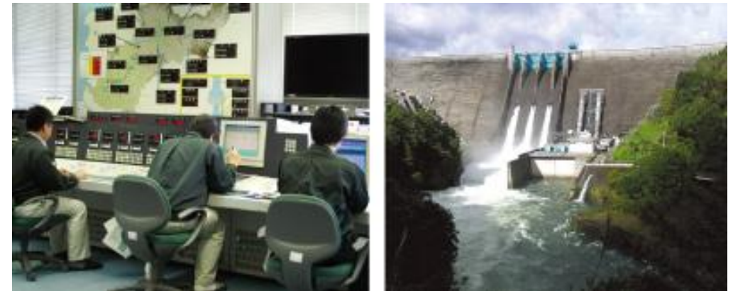
Operación optimizada de la represa para liberar capacidad de almacenamiento para la entrada de la inundación en el período anterior a la descarga máxima
