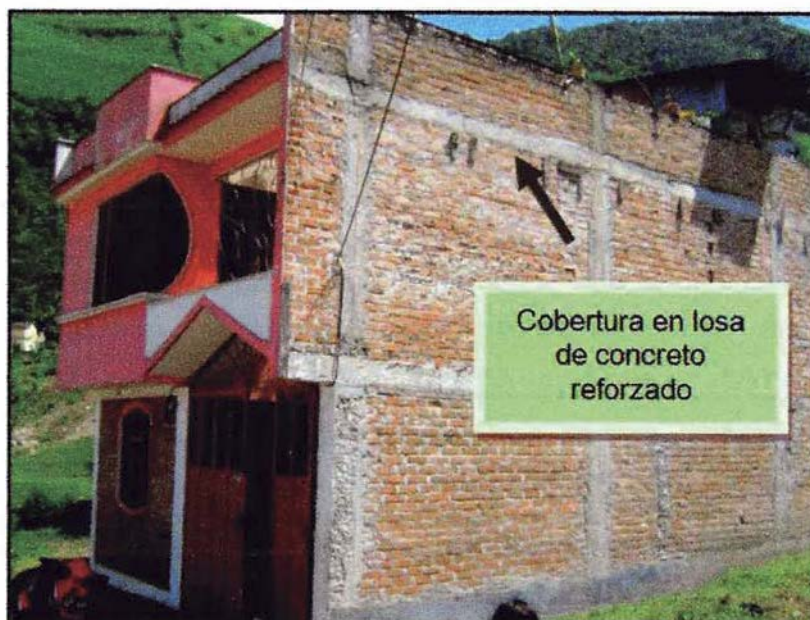
Figura 5. Viviendas con losa de concreto
