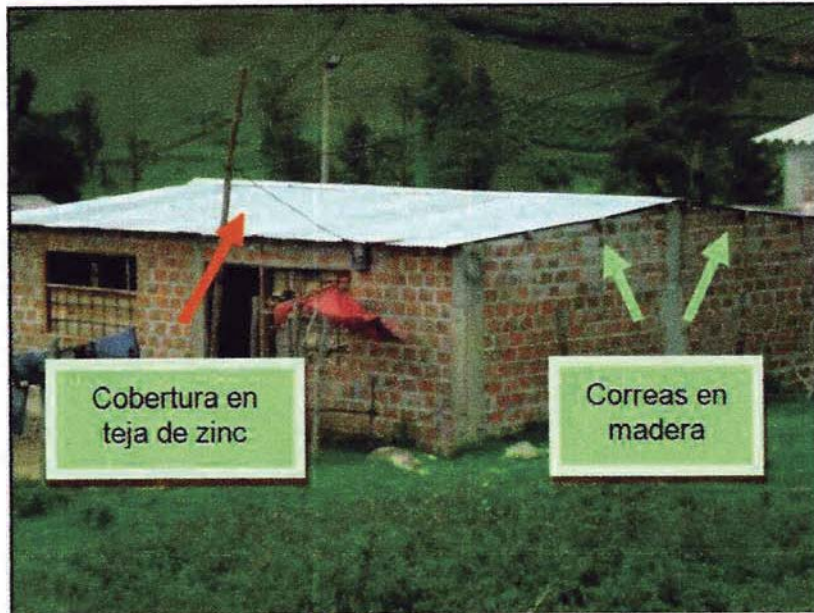
Figura 2. Viviendas con cubierta liviana
