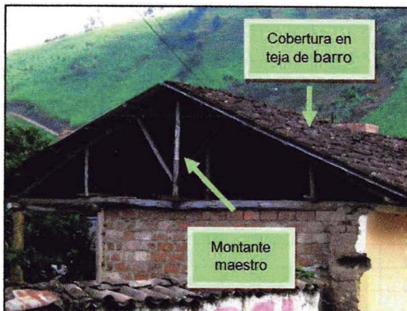
Figura 4. Viviendas con cubierta pesada
