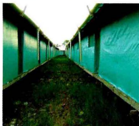
Corregimiento Santiago Apóstol, San Benito Sucre. Foto OIM 2011
