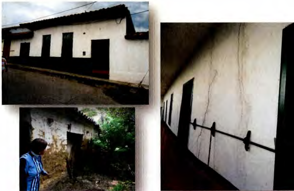
Figura 76. Registro fotográfico Edificación Barrio San Luis. Levantamiento Detallado.
