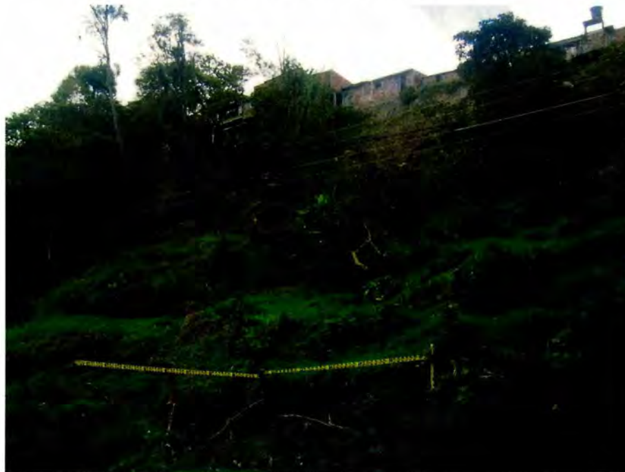
Figura 102. Edificaciones en borde del Escalón de Santa Teresita, en condiciones de amenaza por movimiento de remoción en masa.
