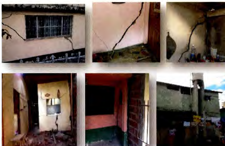
Figura 56. Muestra de registro fotográfico de edificaciones categorizadas en Riesgo alto.
