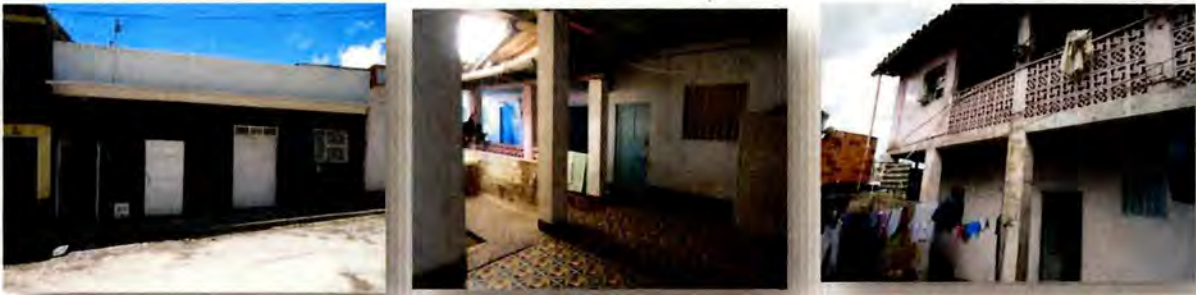
Figura 78. Registro fotográfico Barrio San Luis. Levantamiento Detallado.
