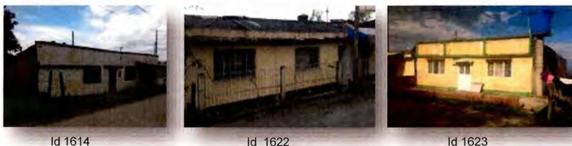
Figura 71. Registro fotográfico SECTOR 6 edificaciones en Riesgo Alto mitigable.
