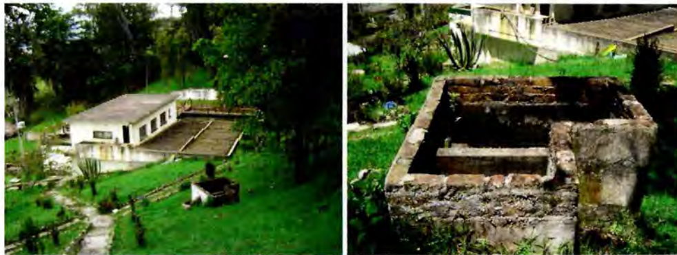
Figura 118. Caja de llegada.
