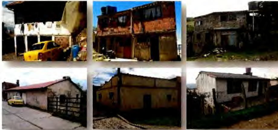
Figura 72. Muestra de registro fotográfico de edificaciones categorizadas en Riesgo medio.
