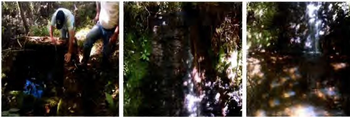
Figura 116. Captación sobre la Quebrada la Peña.
