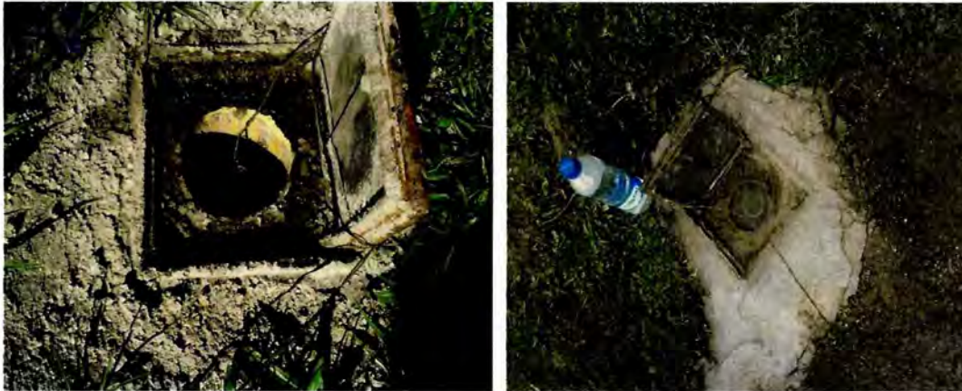
Figura 176. Piezómetros para el monitoreo de aguas subterráneas.
