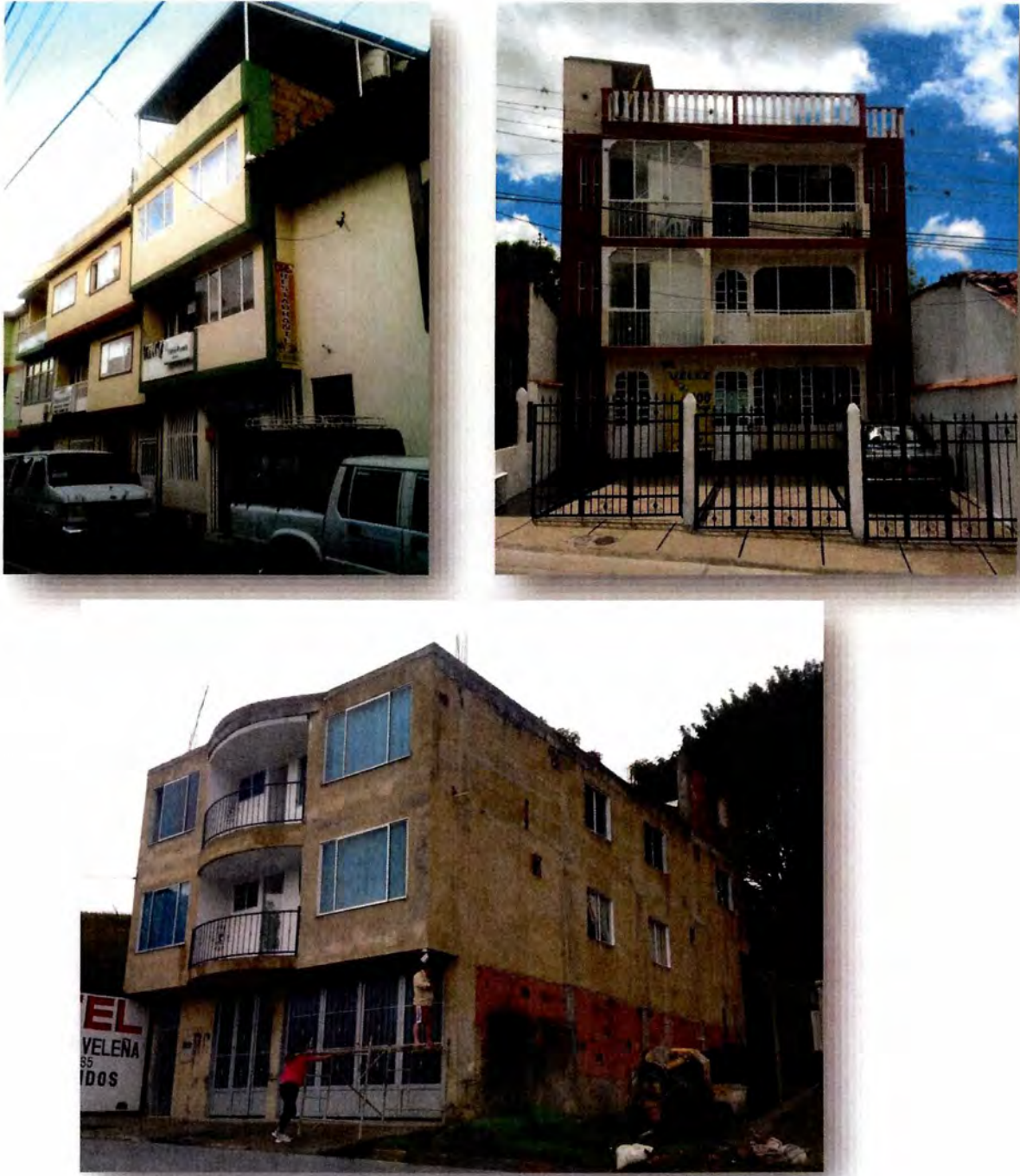
Figura 27. Registro fotográfico, Edificaciones en Hormigón - Levantamiento General Municipio de Vélez.
