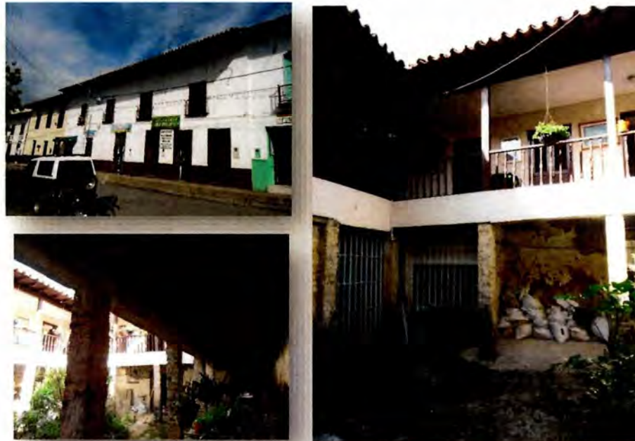
Figura 74. Registro fotográfico Edificación Barrio Centro. Levantamiento Detallado.
