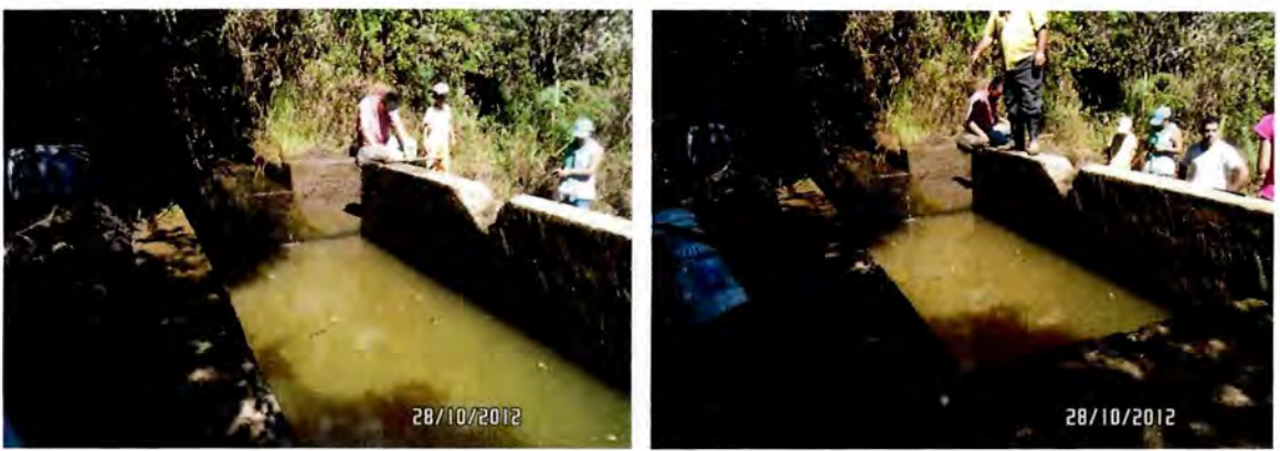
Figura 112. Desarenador sobre la Quebrada el Batán.
