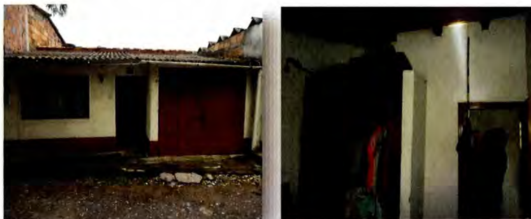
Figura 92. Registro fotográfico Levantamiento Detallado.
