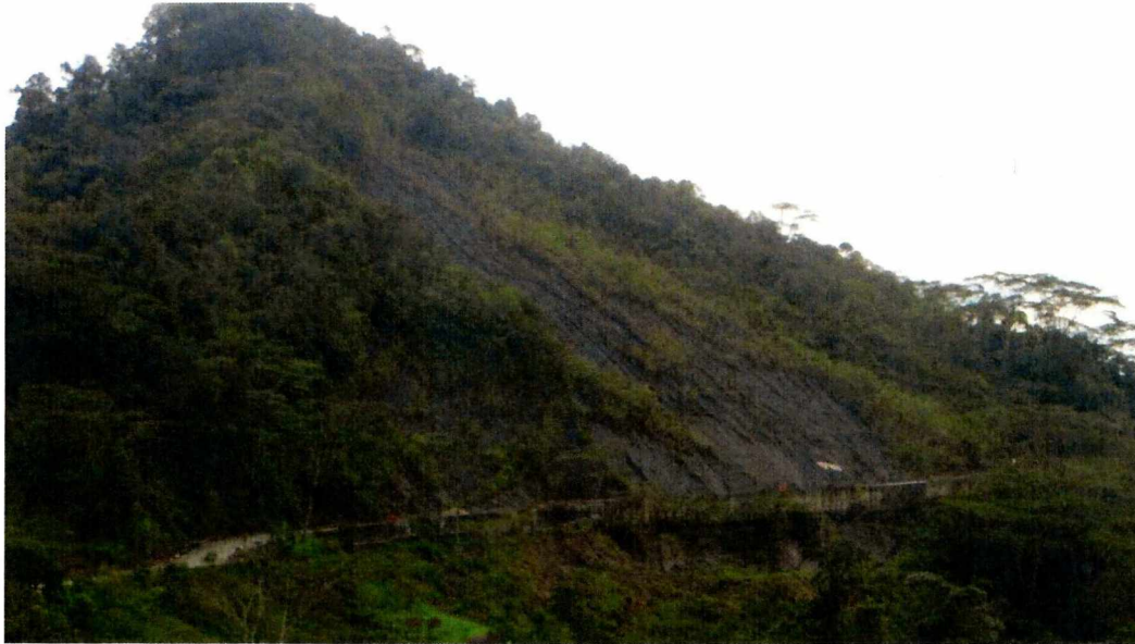
Figura 15. Taludes de corte que coinciden con la estratificación de la Formación Tablazo (K1t), inmediaciones del Km18+330, con la vía hacia Cimitarra a la derecha.
