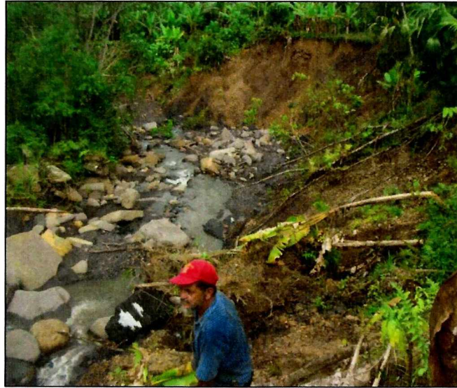
Figura 65. Panorámica de la quebrada La Balsita, que socava y genera el deslizamiento traslacional y flujo extensos sobre la ladera de la margen derecha. Nótese los escombros vegetales que caen al cauce.
