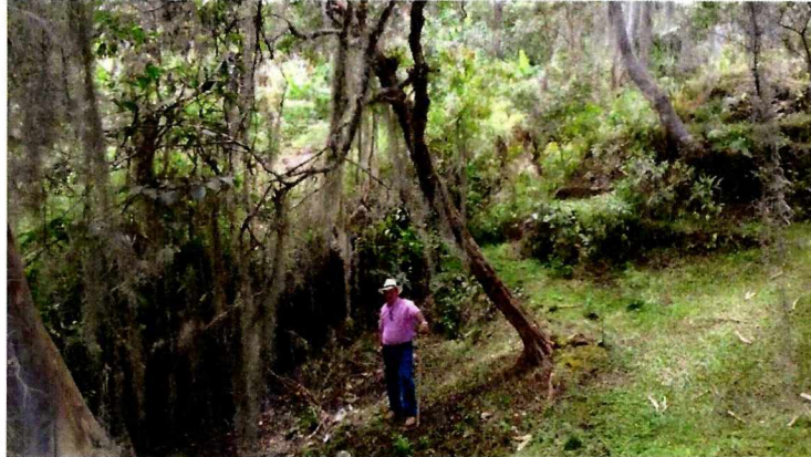
Figura 60. Aspecto del movimiento en masa complejo, inventariado como MM24: Detalle del comportamiento como flujo, con inclinación de los árboles, parte distal de la zona.
