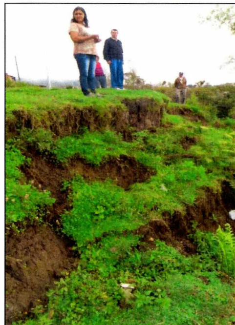
Figura 51. Escarpe de deslizamiento en visita urbana del 19-10-2014.
