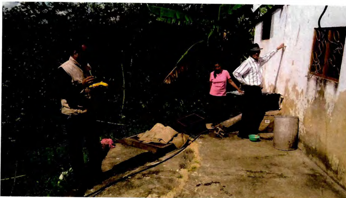
MM21, que origina fisuras en casa. Km62+025, vereda Aco - Peña Blanca, sector Bellavista
