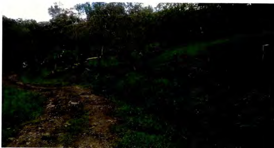
MM23, flujo de 100 m de ancho, que afecta potrero y carretable. Vereda Aco - Peña Blanca, sector Bellavista
