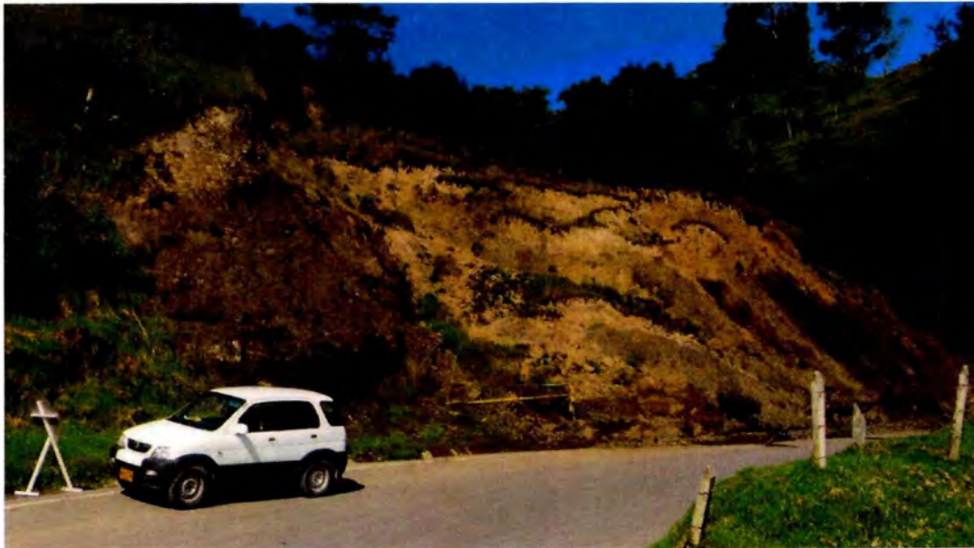
Talud de corte vial, del Km45+570, con el MM16
