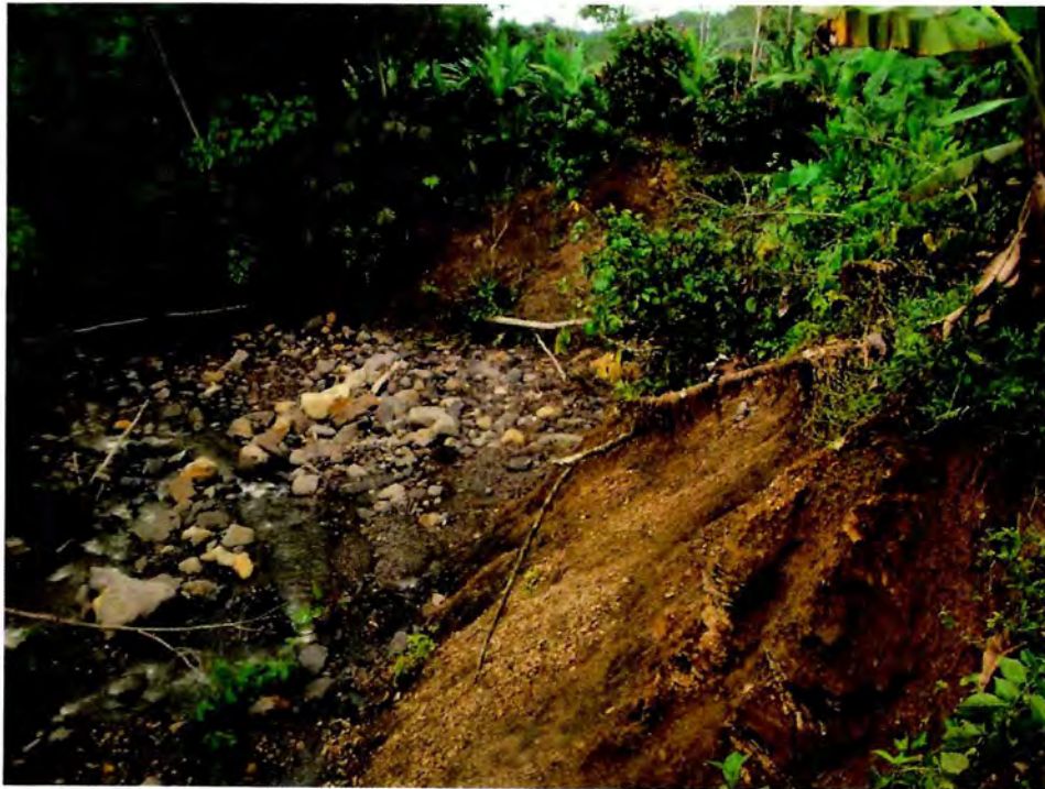
MM34, inestabilidad combinada y debida a socavación en la base por la quebrada la Balsita. De calificación 5, en la vereda Limoncito
