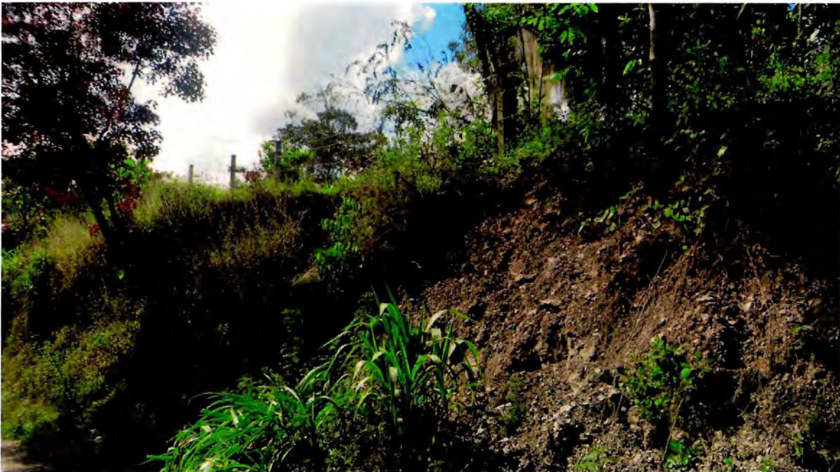
MM25, deslizamiento traslacional en la vereda Guayabal
