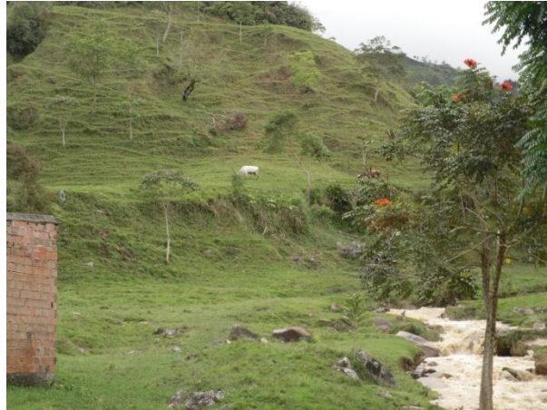
Fotografía 5-4 Deslizamiento cercano a quebrada Apucarpo
