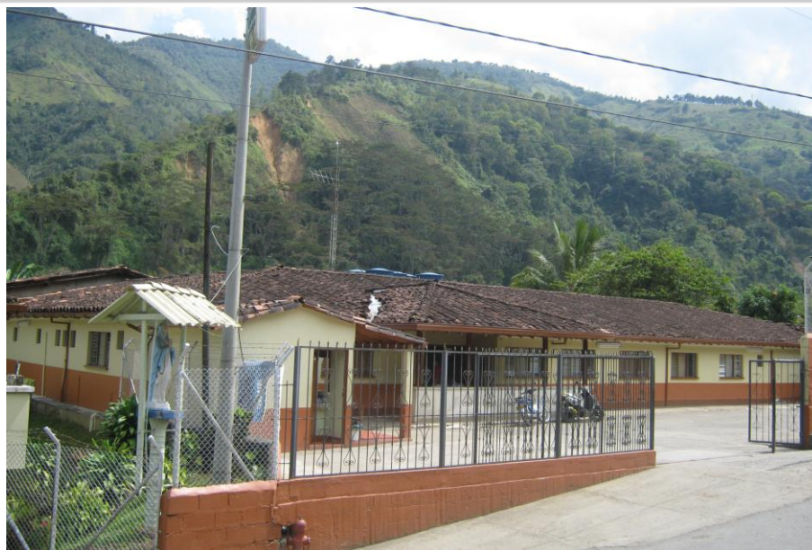
Fotografía 4 - 9 Hospital San Carlos
