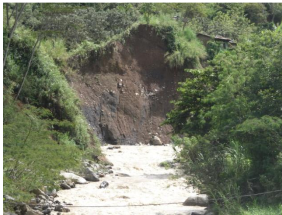
Fotografía 5-9 Inestabilidad de márgenes por socavación lateral
