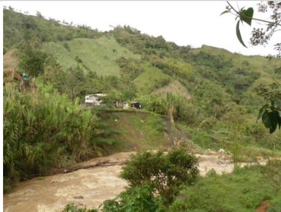
Fotografía 5-8 Comienzos de inestabilidad de márgenes.
