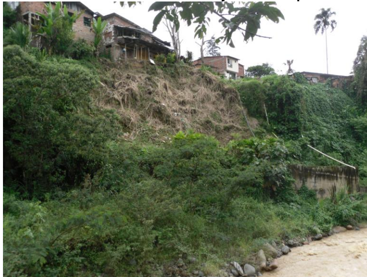
Fotografía 3-9 Laderas circundantes al río y afectadas por deslizamientos.
