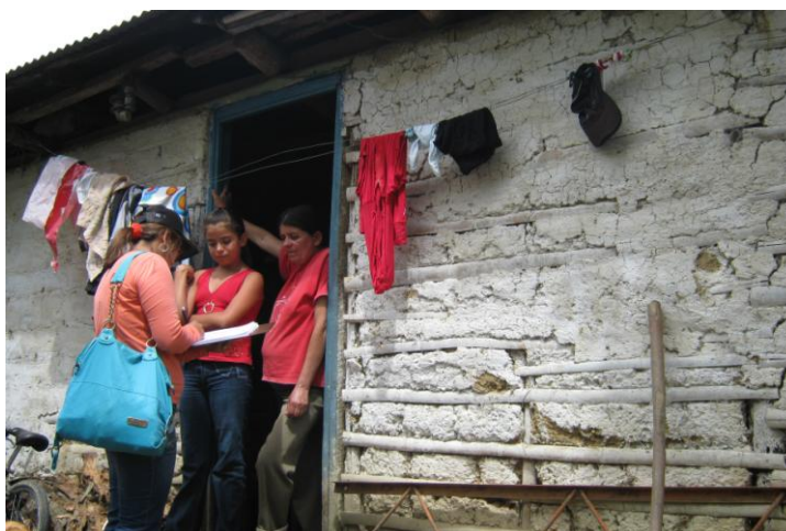
Fotografía 4 - 15 Vivienda en Bahareque – Sector Cristo Rey.
