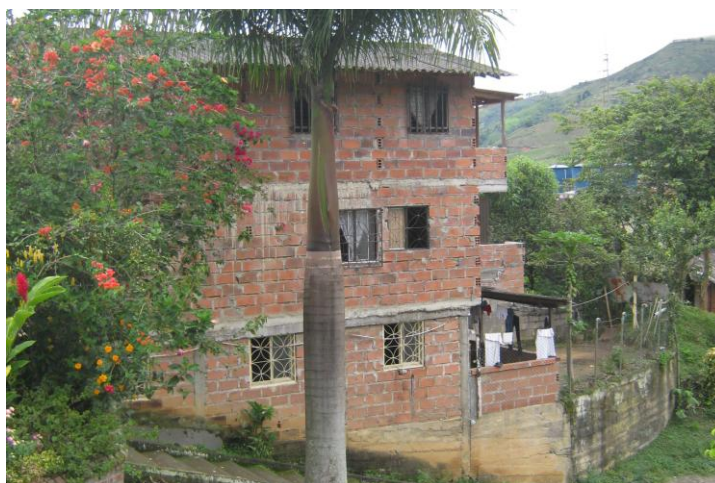
Fotografía 4 - 14 Viviendas en Mampostería (Bloque o ladrillo) – Cerca al Hospital San Carlos - Cañasgordas.
