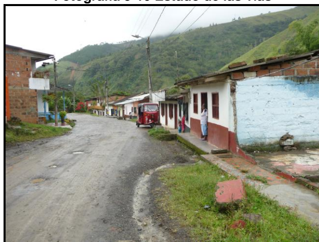
Fotografía 3-10 Estado de las vías
