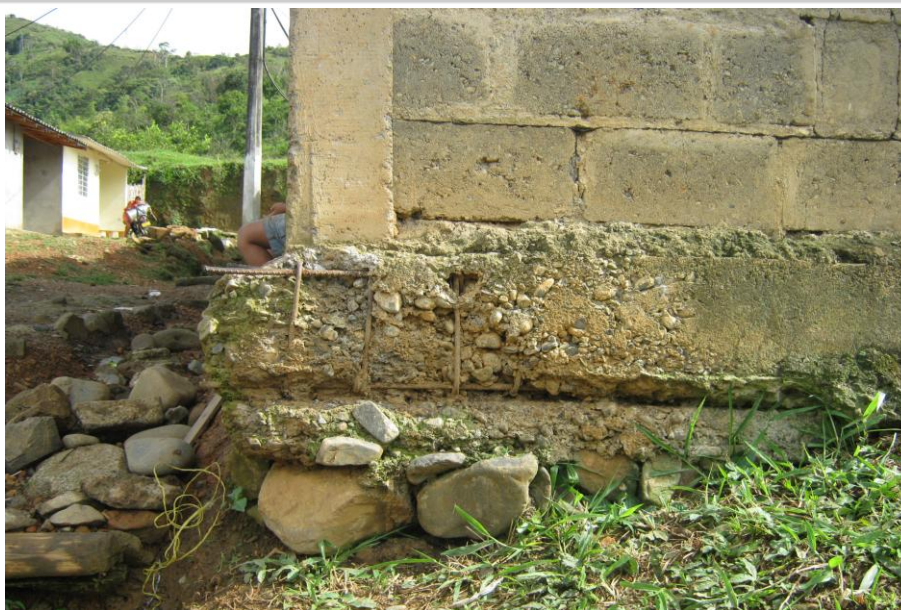
Fotografía 4 - 12 . Cimentación de las viviendas barrio La Esperanza.
