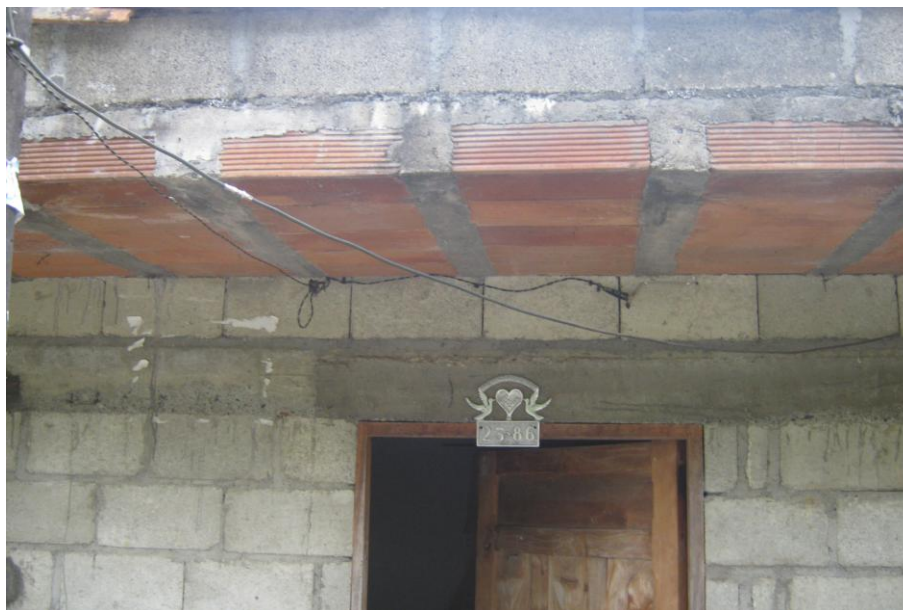
Fotografía 4 - 16 Vivienda con placa de entrepiso aligerada con bloque.
