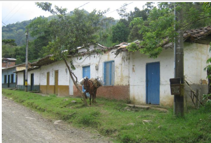
Fotografía 4 - 13 Viviendas en Tapia Pisada, Adobe. – barrio Versailles.
