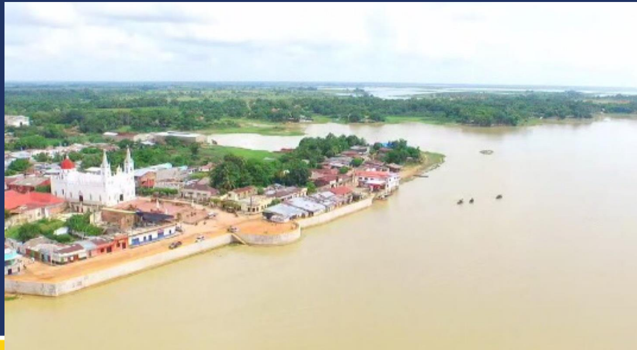
Muro de contención Ayapel, Córdoba
