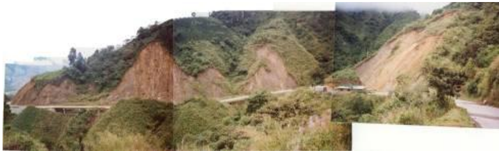
Figura 45. Deslizamientos carretera Florencia-Suaza
