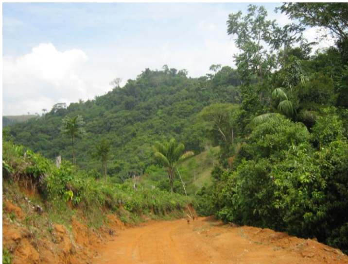
Figura 15: Tramo de la vía en Construcción
