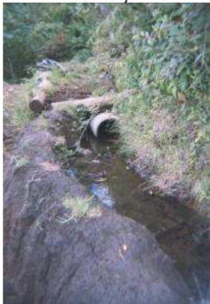
**Fotografía 71.** Filtración de Canal en tierra. Condiciones frecuentes.
