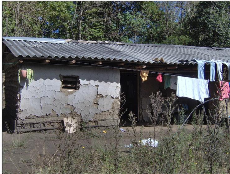
**Fotografía 2.** Vivienda con paredes exteriores en ladrillo y esterilla, presentando alto nivel de deterioro (Vereda Pisojé Alto)
