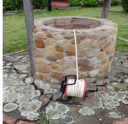
Fotografía 2. Medición de la altura de la lámina de agua.
