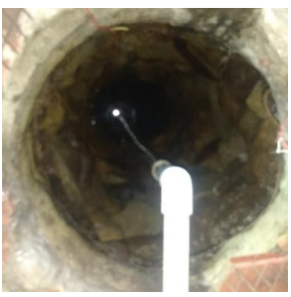
Fotografía 15. Inspección del estado actual del pozo.
