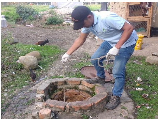
Fotografía 35. Inspección del estado actual del pozo.
