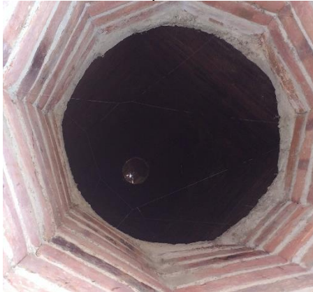
Fotografía 3. Inspección del estado actual del pozo.
