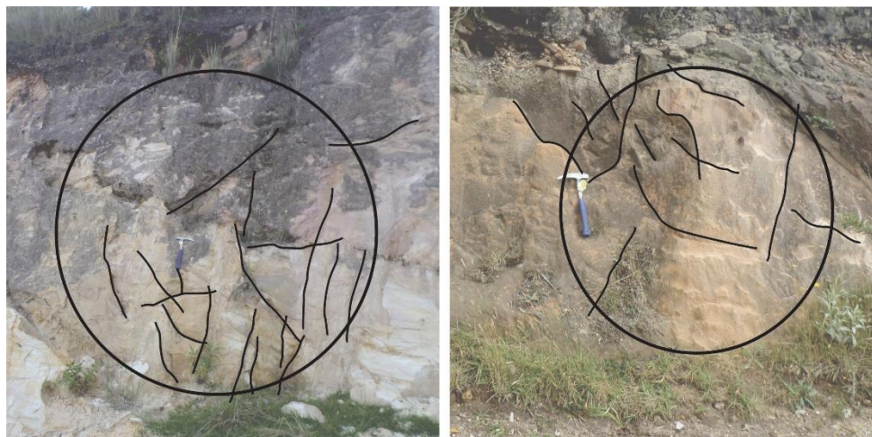
Imagen 30. Ventanas de muestra sobre las cuales se marcan los principales patrones de fracturamiento y las fracturas asociadas a estos para la Formación la Regadera.
