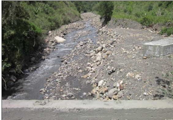
Figura 5.192. Vista general Río Rucio punto 83
