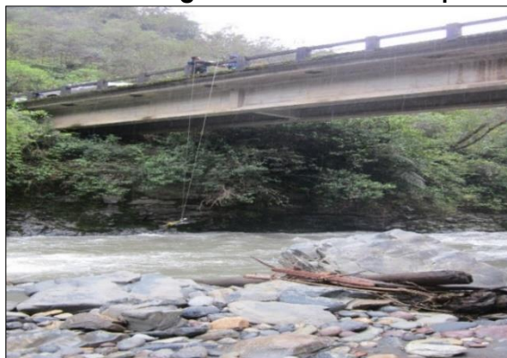
Figura 5.202. Vista general Río Farallones punto 167
