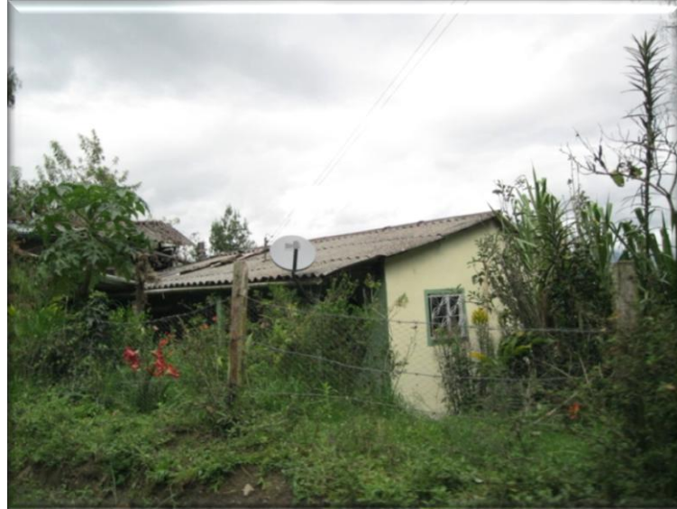
Fotografía 9. Servicio de televisión por cable, zona rural vereda Yonama Fuente: Consultor
