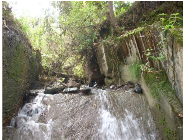
Foto 7.64. Bocatoma en la Quebrada La Moya
