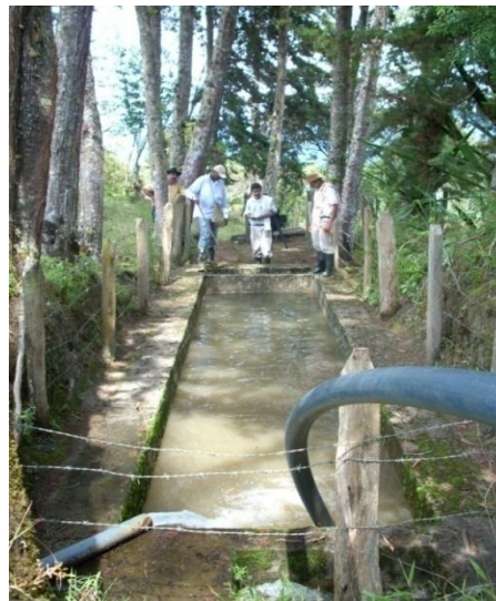
Foto 7.65. Desarenador en la Bocatoma de la Quebrada La Moya
