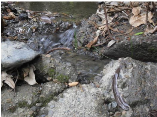
Foto 7.5. Bocatoma Acueducto Gachalá vereda Escobal
