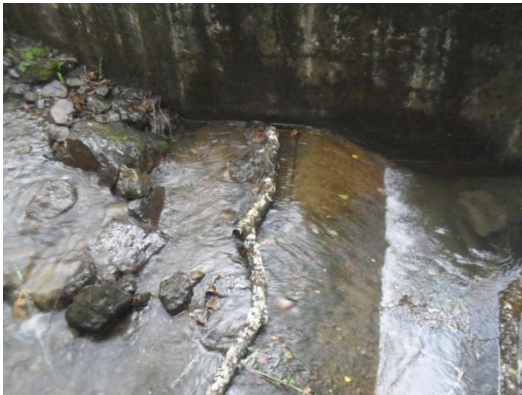
Foto 7.2. Bocatoma Acueducto Gama vereda La Unión
