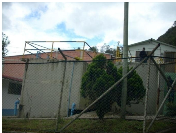
Foto 7.28. Planta de potabilización de agua municipio de Medina
