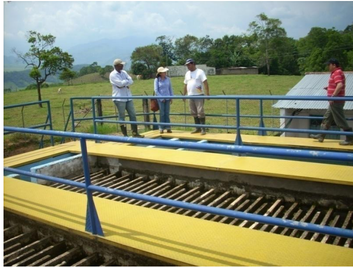
Foto 7-8. Planta de tratamiento del acueducto municipal de Medina.
