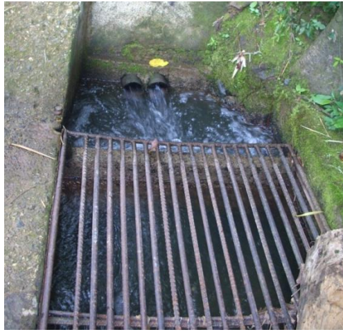
Foto 7-2. Infraestructura de la bocatoma del acueducto
