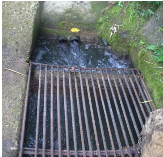
Foto 7.25. Infraestructura de la bocatoma del acueducto
