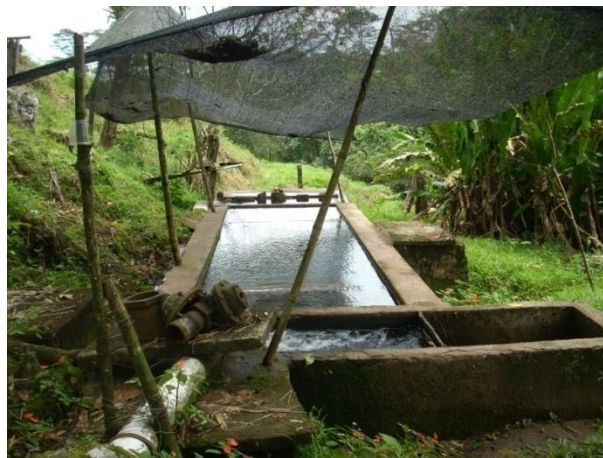
Foto 7.26 Desarenador en la bocatoma del acueducto
