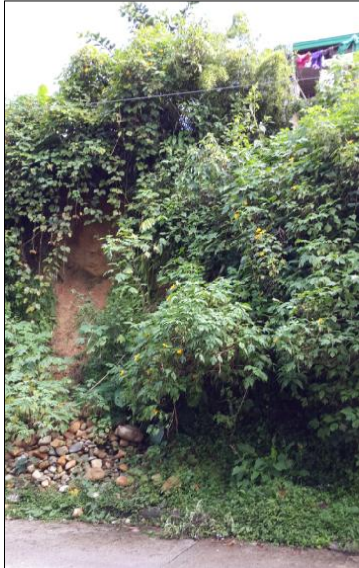
Fotografía 3. Movimiento en el sector El Barranco, barrio Zulia. Obsérvese la cercanía de la vivienda en la parte alta del talud.
