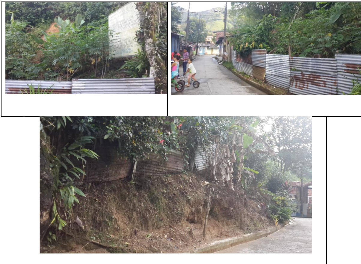
Mosaico fotografías 4. Villaoriente. Talud declarado en el 97 por el Dapard como propenso a deslizamiento. Nótese el uso inapropiado del suelo (sembrado de yuca y construcciones sin normas)
