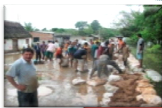
N° 1 - Escenario de Riesgo por Deslizamiento y Erosión en Cabecera Municipal y Rural
