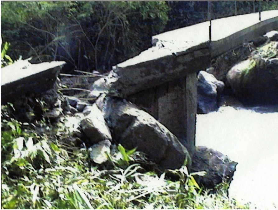
Foto 13. Daño por desbordamiento de cauce de la quebrada el Retiro, en la vía Dominguito a la vereda el Toro sitio La Quinta.
