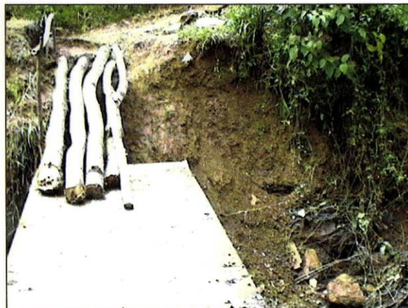
12. Daño por deslizamiento en la vereda Dominguito, que afecta la batea y el puente peatonal.
