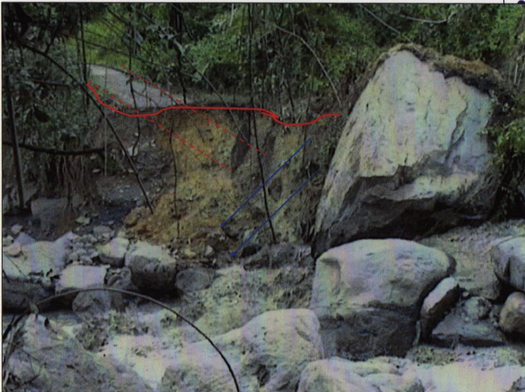
Foto 8. Deslizamiento en la quebrada El retiro, amenaza para el puente peatonal.
