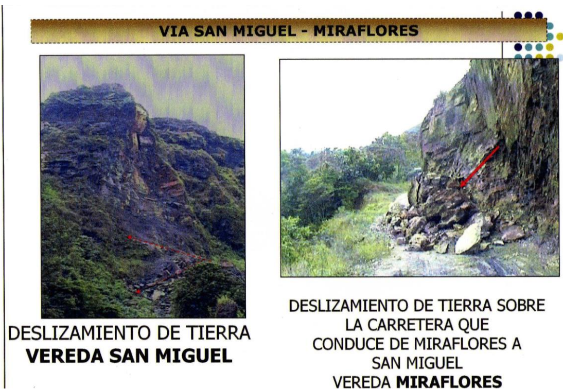
Foto 10. La vía de la vereda San Miguel a la Vereda Miraflores presenta riesgo por deslizamiento en varios puntos.
