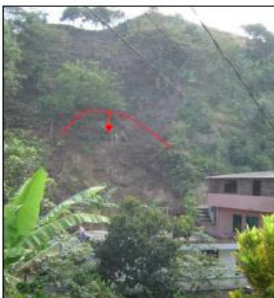
FOTO 29. Deslizamiento detrás de la vivienda localizada en la calle 15 # 4C-44 INT. 150, sector "Los Tanques". El proceso mostrado corresponde a un movimiento en masa de volumen pequeño desarrollado en suelos residuales de Batolito, se encuentra latente y tiene una superficie de falla poco profunda. Este deslizamiento afecta dos viviendas localizadas hacia la margen derecha de la quebrada La López.
