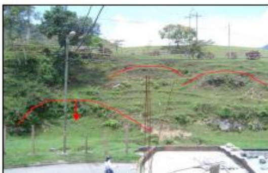
FOTO 30. Movimientos en masa pequeños localizados al frente de la vivienda ubicada en la calle 13 # 5-02. Los procesos señalados son antiguos movimientos de volumen pequeño, que se presentan por desestabilización de los suelos debido a usos agropecuarios y puntualmente efectos de socavamiento.
