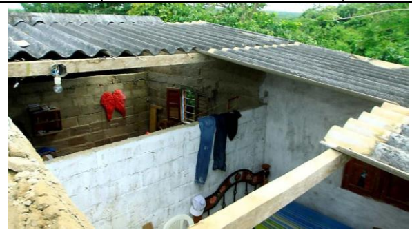
Fuente el Universal 2016 Mal amarre de techos de asbesto
