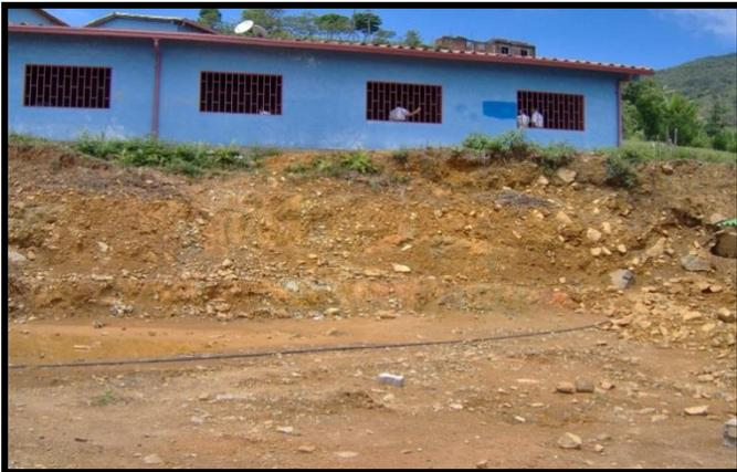
Talud expuesto a procesos de erosión hídrica superficial que paulatinamente puede evolucionar a erosión concentrada y posteriormente movimientos en masa con potencialidad de afectación sobre la infraestructura. Sector del Colegio.
