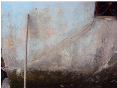
**FOTOGRAFIA 19 FISURAMIENTO DEBIDO AL MOVIMIENTO DEL TERRENO**
