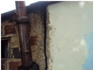
**FOTOGRAFIA 26 SEPARACION DE LAS PAREDES VISTA DESDE AFUERA**
