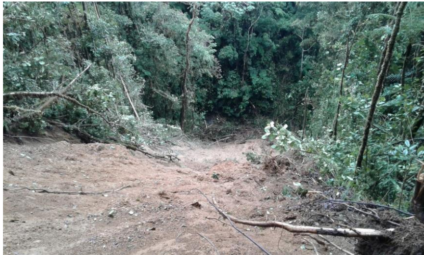
fotografía 8: deslizamientos sobre la quebrada Arrayanal
