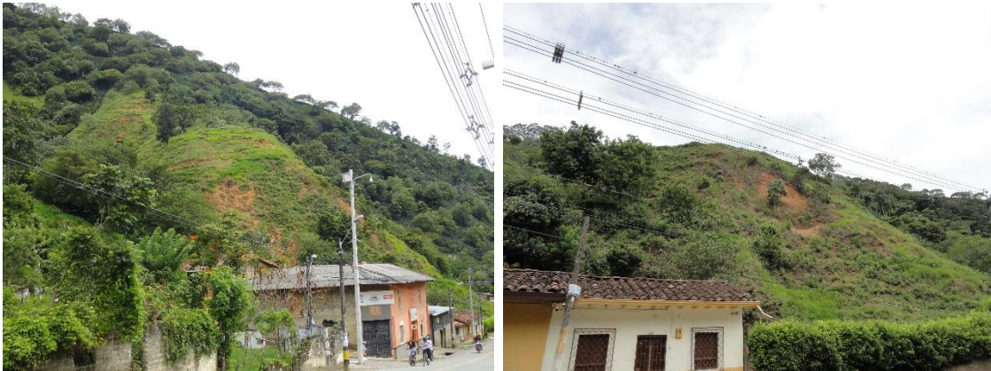
Foto 59. Características de los suelos residuales de la Formación Penderisco – Miembro Urrao en el barrio Chapinero.
