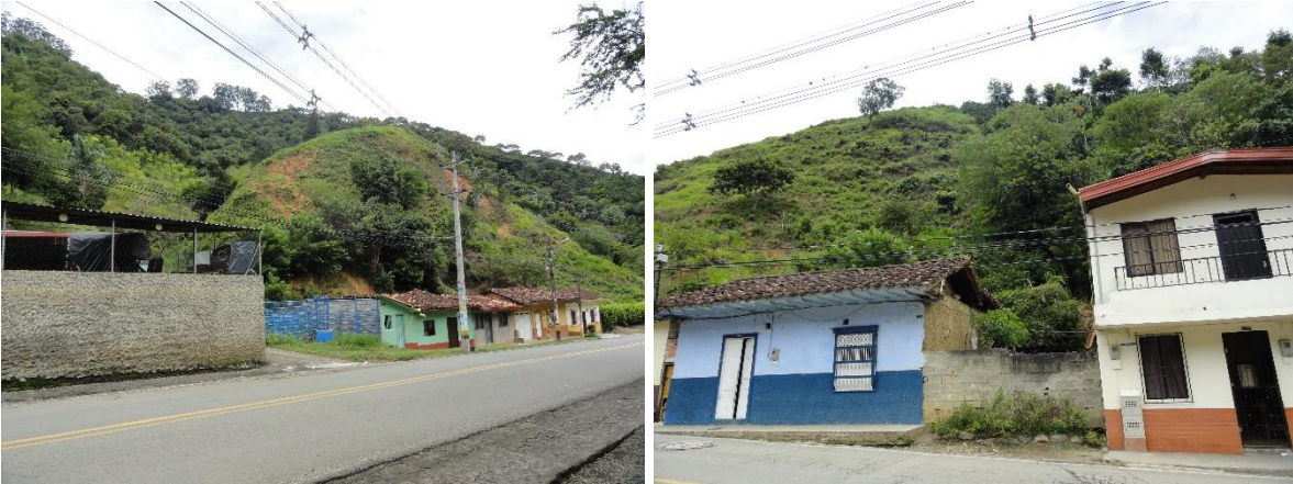
Foto 88. Proceso de erosión superficial en las laderas que bordean la cabecera.
