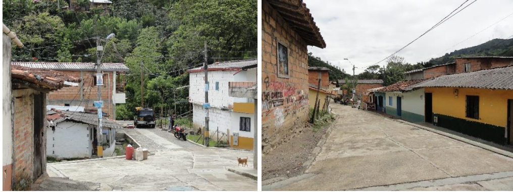
Foto 98. Características de las construcciones localizadas contiguas a la quebrada La Linda en el barrio La Cabaña
