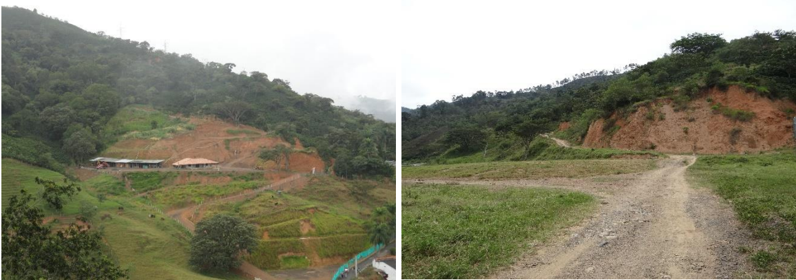
Foto 55. Características de los suelos residuales de la Formación Penderisco – Miembro Urrao en cortes realizados en la margen derecha de la entrada principal (Der.) y en la vía hacia el cementerio (Izq.)
