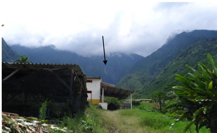
Foto 32. Escarpe faceteado en la vereda Farallones, sector Ardedero.
