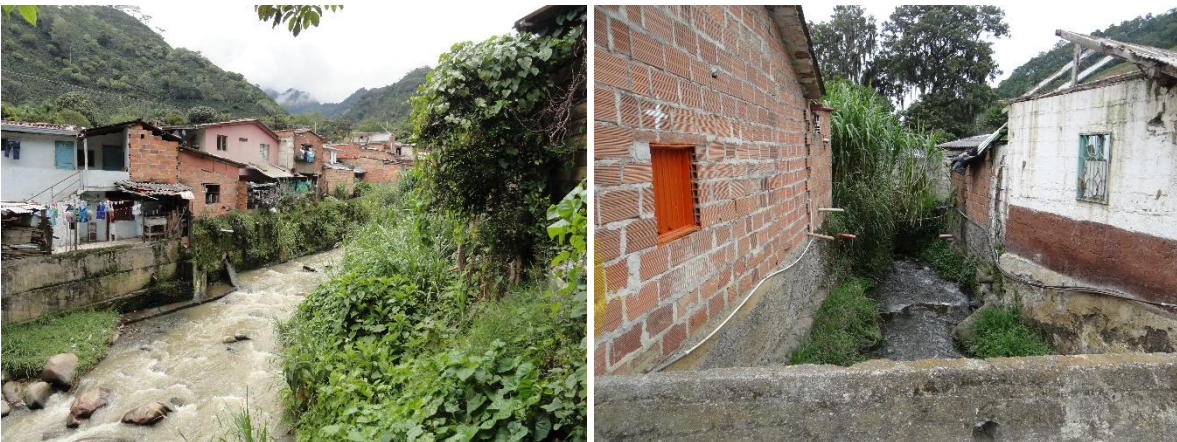
Foto 89. Ocupación del cauce de la quebrada La Linda con viviendas.
