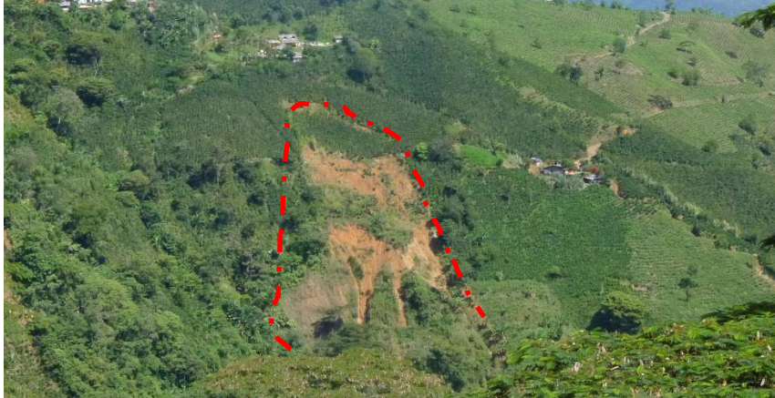
Foto 47. Deslizamiento rotacional sobre vertiente occidental de Alfonso López
