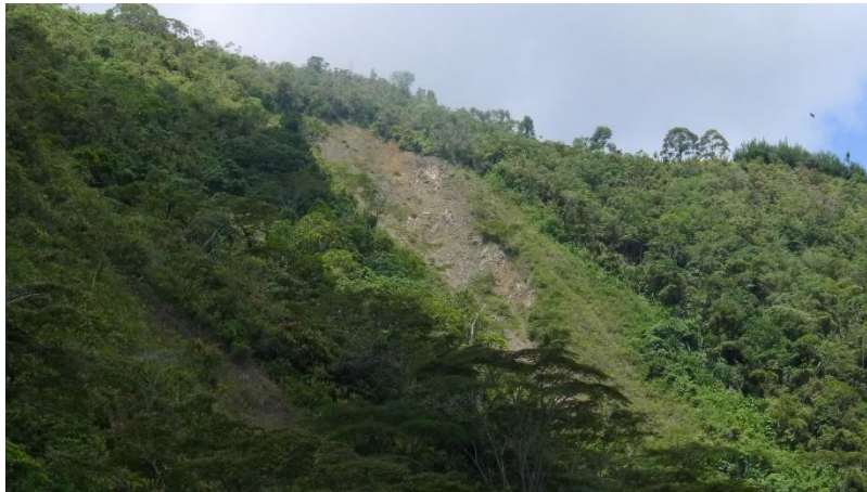
Foto 46. Deslizamiento traslacional cerca al centro poblado de Alfonso López
