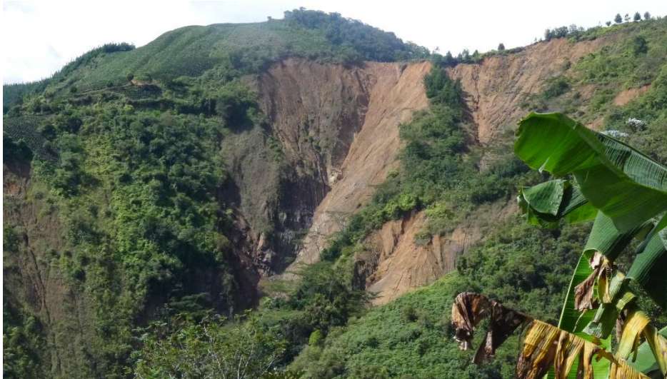
Foto 49. Deslizamiento traslacional sobre la vía que comunica las veredas Remolino y San Miguel
