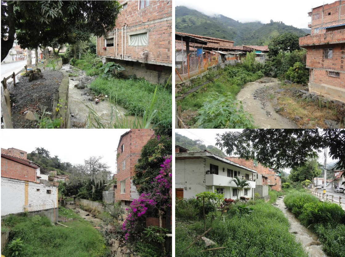
Foto 69. Depósitos recientes de la quebrada Manzanillo.
