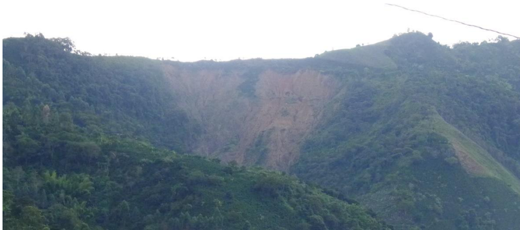
Foto 52. Deslizamientos sector Alto de los Jaramillo
