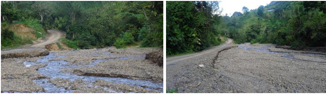
Foto 53. Procesos de socavación asociados al cauce de la quebrada La Angostura
