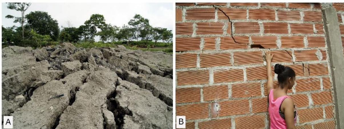
Figura 29. Volcán de lodo Alto de Mulatos. A) Levantamiento del suelo en el área del cráter principal que evidencia grietas radiales de amplitudes variable. B) Grietas por asentamiento del suelo en viviendas del área urbana del Alto de Mulatos. Fotos: Alberto Vivas Narváez (8/12/2018).
