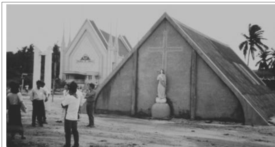
Figura 5. Enterramiento causado a iglesia por paso de flujo de lodos en población aledaña al volcán Pinatubo, Filipinas.
