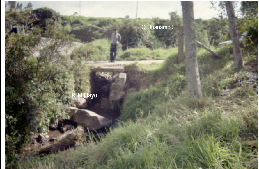
Río Mijitayo en desembocadura de la quebrada Juanambú. Cruce de San Felipe. El ancho del puente de 1.40m y altura de 1,70 m, indican el bajo caudal que ha tenido el río
