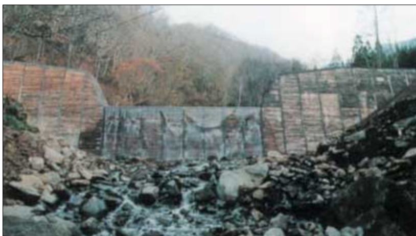
Figura 6. Muros de contención para control de crecientes, flujos de lodo y escombros.
