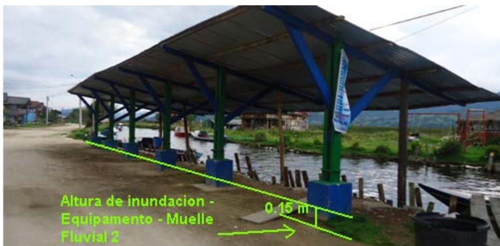
Figura 111. Estado infraestructura, muelle fluvial, corregimiento El Encano, municipio de Pasto.
