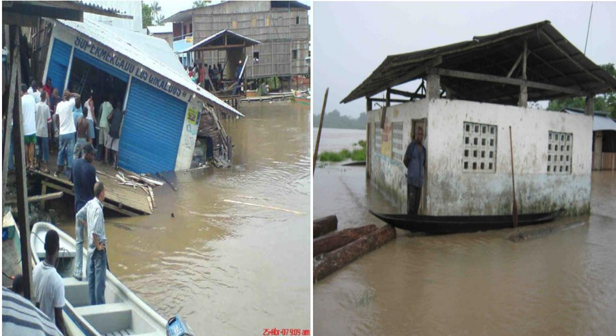
Figura 36. Afectación por socavación lateral municipio de Olaya Herrera Fuente: CLOPAD.
