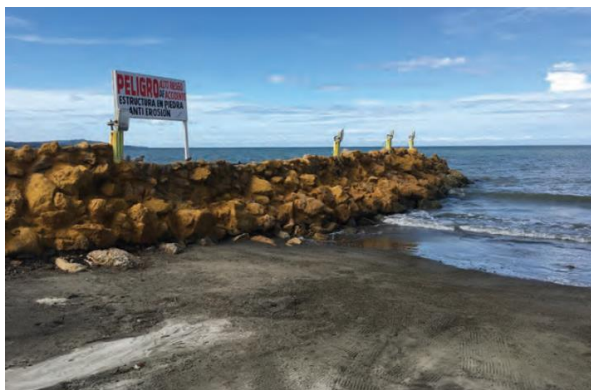
Figura 5. Medidas estructurales o duras frente a la erosión costera en la costa Caribe Colombiana, espolones rompe olas (INVEMAR 2018).
