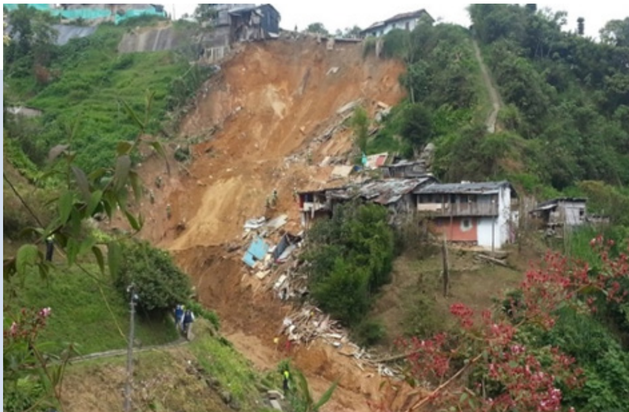
Deslizamiento traslacional, Manizales (Caldas), barrio El Guamo. Fuente: UNGRD (2016)
