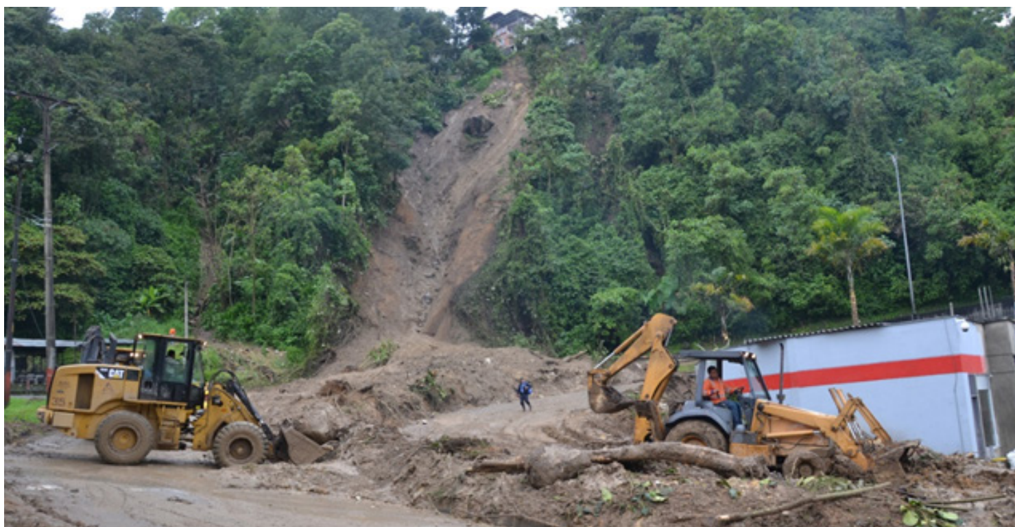
Movimiento en masa mixto, deslizamiento traslacional y flujo de lodos, Manizales (Caldas). Fuente: UNGRD (19/04/2017)
