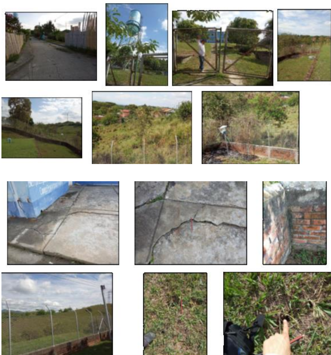
Figura 40 Evidencias de reptación en el barrio Las Brisas, sector Acuavalle
