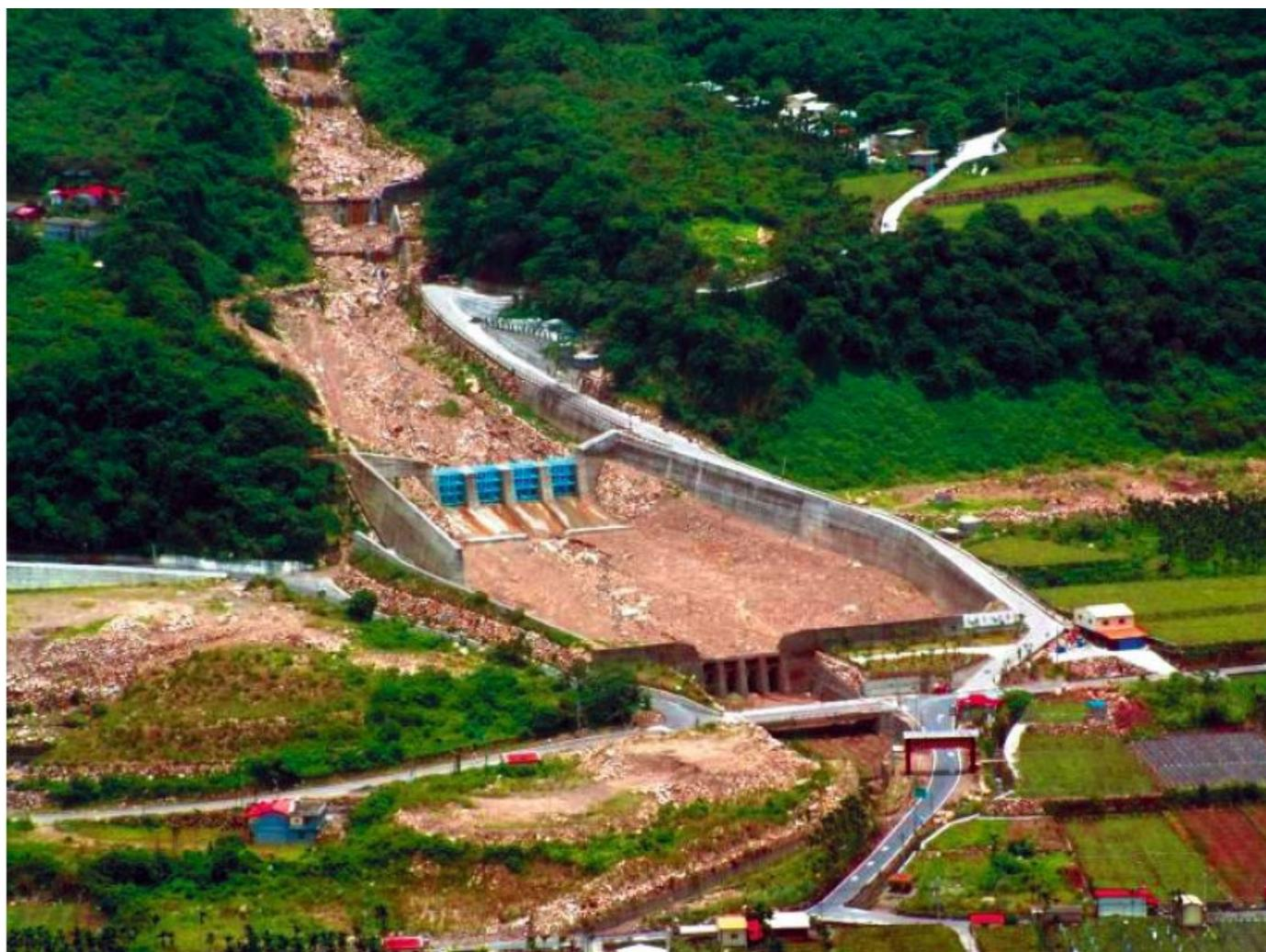
*Contramedidas estructurales contra el flujo de escombros, como presas de Sabo, barreras de escombros y cuencas de escombros, en Fengqiu en la cuenca del arroyo Chenyoulan. La foto muestra una gran cuenca de escombros con una capacidad diseñada de 80.000 m<sup>3</sup>. Fue construido en 1999 y luego dividido por una presa de hendidura de tipo rejilla (como se muestra en color azul) en 2000.(Foto: Profesor C.C. Wu - Tomada del Libro: Debris Flow Hazards and Related Phenomena, 2005).*
