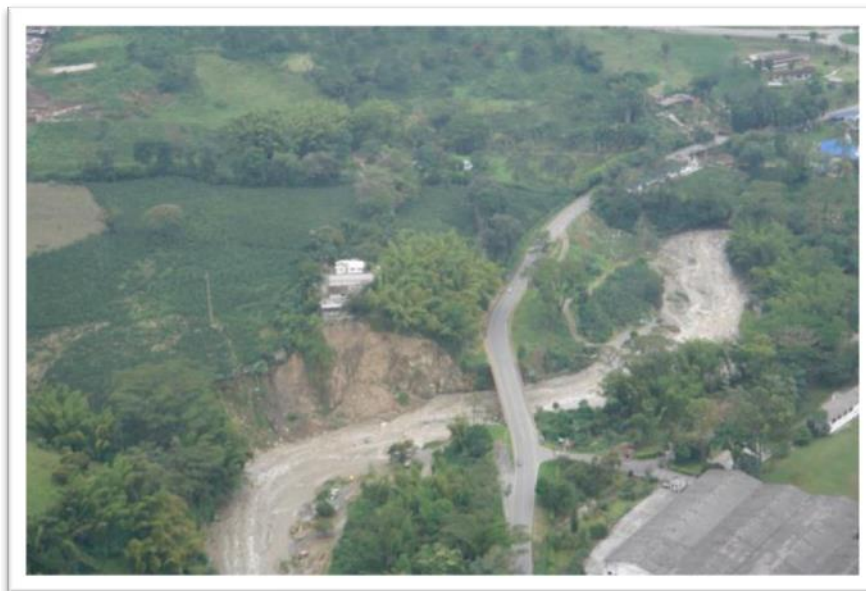
Foto 8, Puente sobre el rio Chinchiná – sector Cenicafe, este puente se vio afectado en el año 1985
