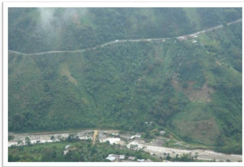
Foto 10, Puente sobre el río Chinchiná – sector Nueva Primavera
