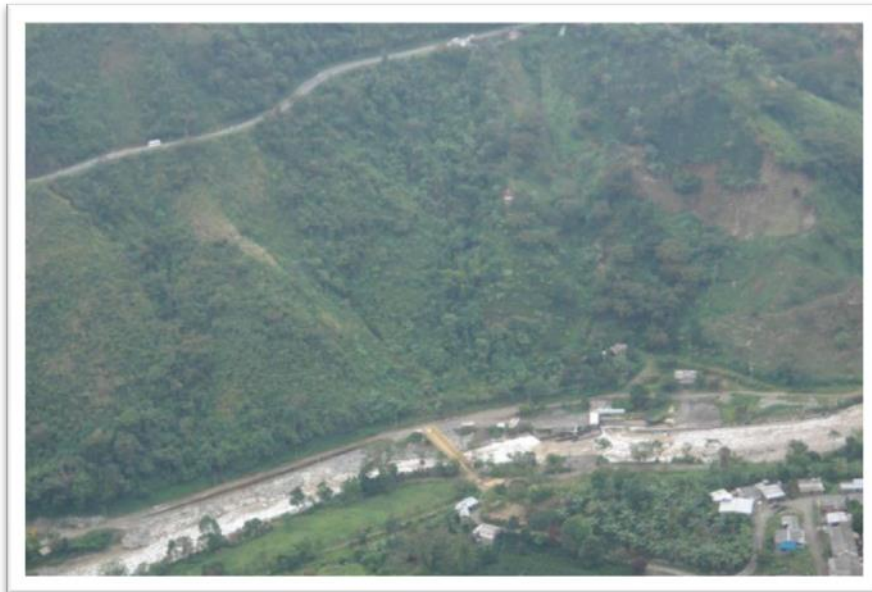
Foto 2, Nueva Primavera en el municipio de Villamaría, se evidencia el puente ubicado en este sector, al igual que la subestación de la CHEC y las viviendas de la vereda Nueva Primavera en cercanías al río
