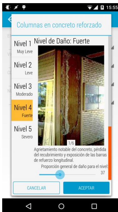
Figura 3-12 Nivel de daño de los elementos estructurales
