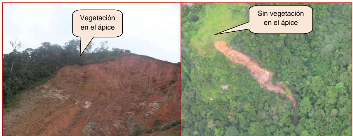
Figura 15. Deslizamiento con vegetación en el ápice de la ladera y sin vegetación en el ápice
