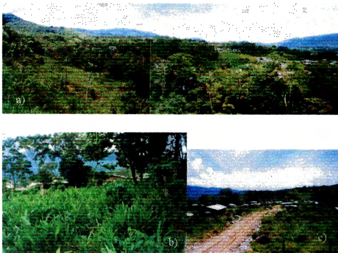
Foto 28. a) Panorámica de los suelos dejados por el río Sangoyaco y quebrada Taruca, las casas observadas corresponden a las urbanizaciones la Floresta y San Miguel; b) zona de protección (30m) dejada por la urbanización Jordán, en la quebrada Taruca; y c) urbanización la Floresta.
